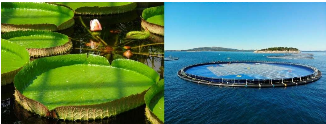
圖 13. Ocean Sun荷葉概念之浮動光電系統架構
