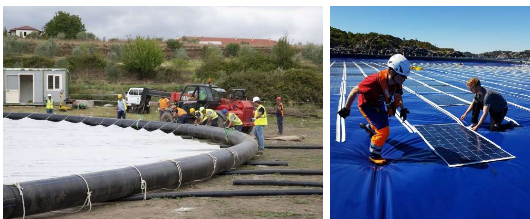
圖 16. Ocean Sun浮動光電建置工程(Ocean Sun網路圖資)
