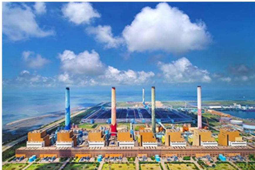
圖 1.台中電廠現況
