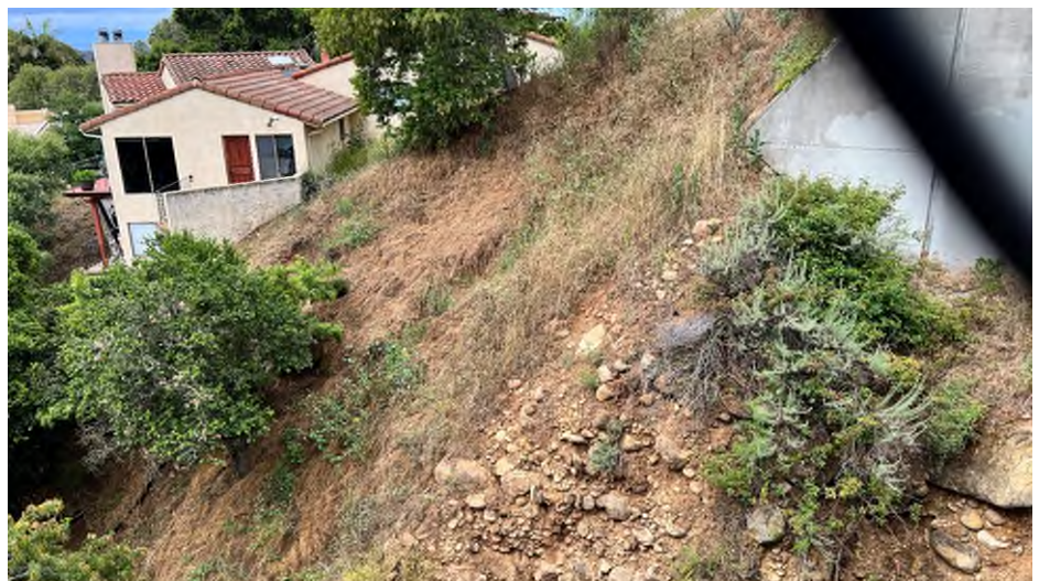
圖 39 Route 192 橋梁旁邊坡嚴重冲刷裸露
