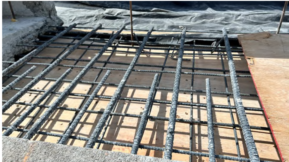
圖 66 Route 134 橋梁更新混凝土護欄及橋面板
