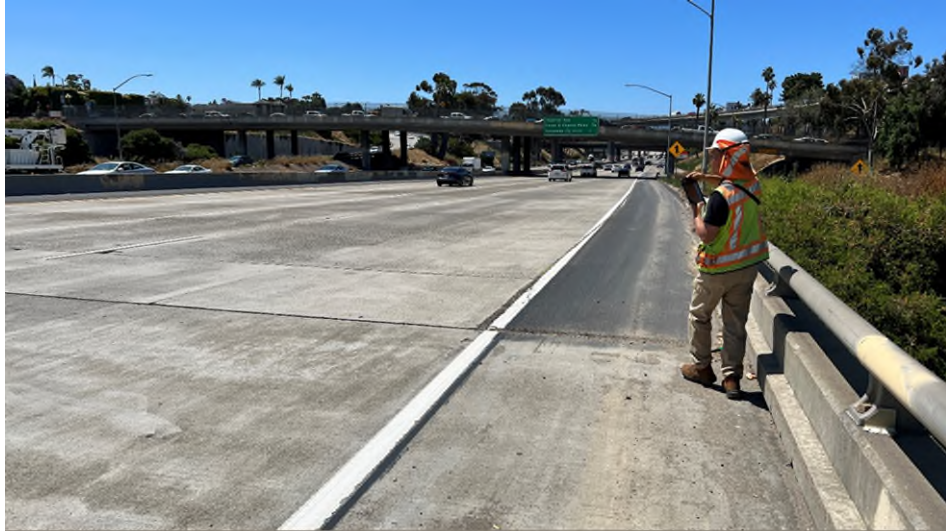
圖 69 San Diego 市區 I-5 單向即有 5 車道，車流量又高，檢查人員僅能在路肩巡檢剛性鋪面狀況，即便在路肩亦十分危險
