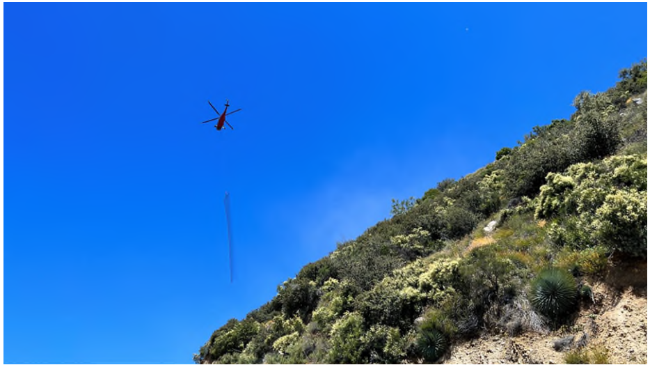
圖 30 Route 39 邊坡保護工法，於坡度過於陡峭且高度甚高的裸露邊坡，採以直升機吊掛掛網方式進行施工
