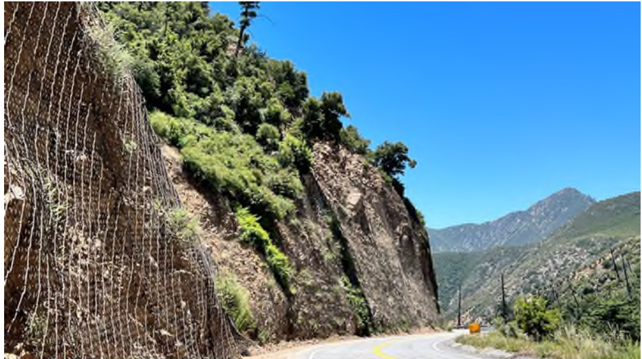
圖 32 Route 39 邊坡掛網保護完成情形
