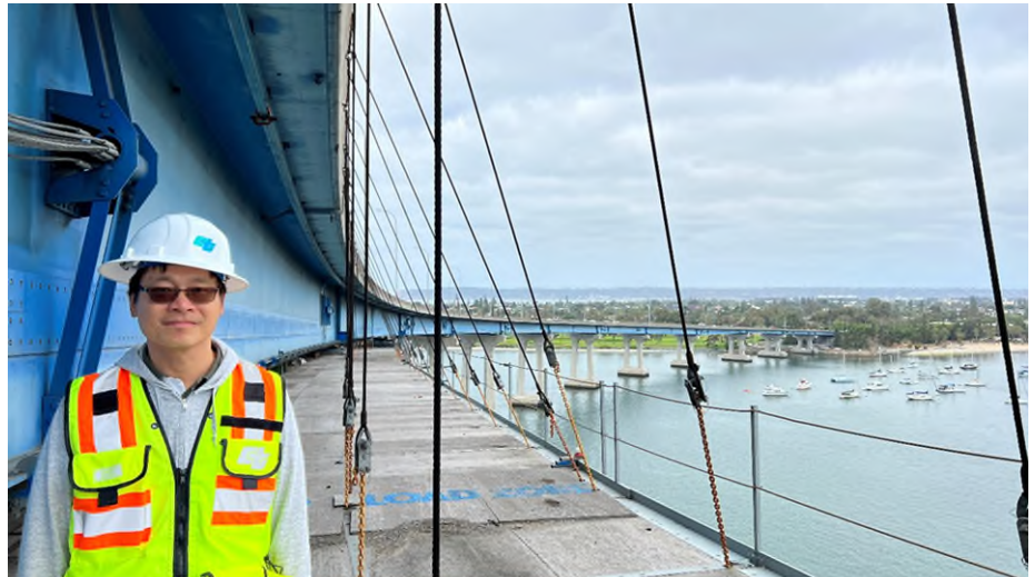
圖 63 Coronado Bridge 鋼橋油漆工程搭設臨時維修平台
