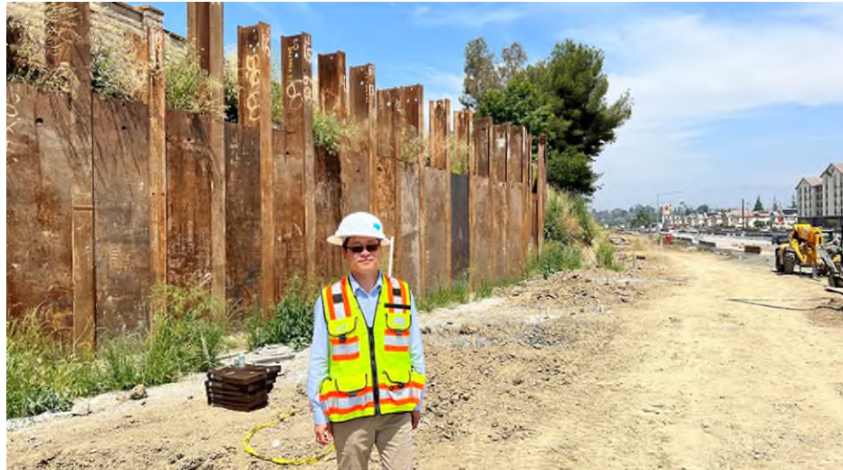
圖 65 Route 71 拓寬工程施作 Soldier Pile 擋土
