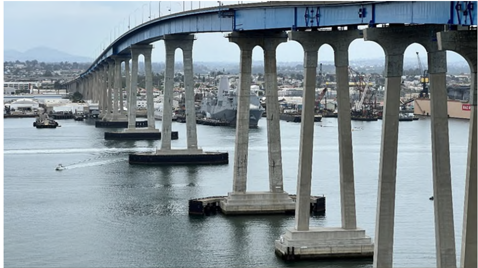
圖 59 Coronado Bridge，主航道橫跨 3 跨，橋墩設有保護防撞設施
