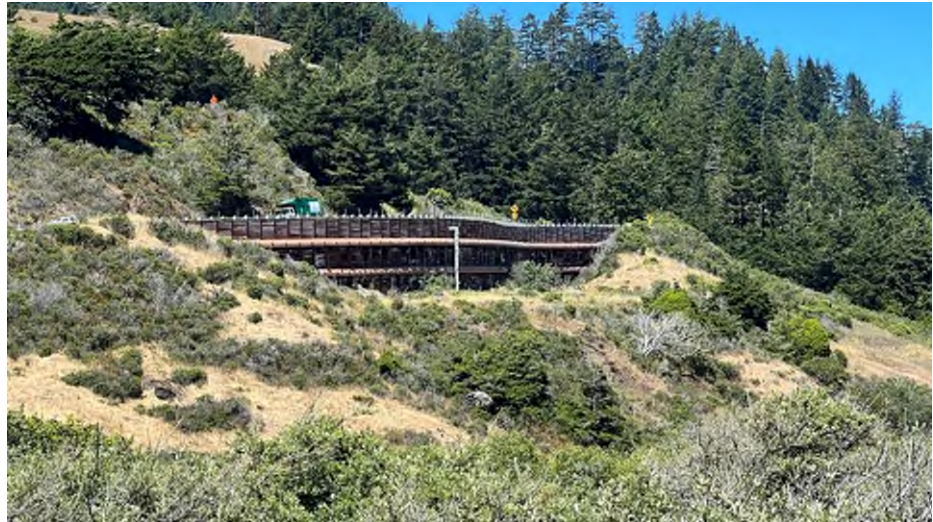
圖 49 Route 1 公路下邊坡坍方，施作保護工
