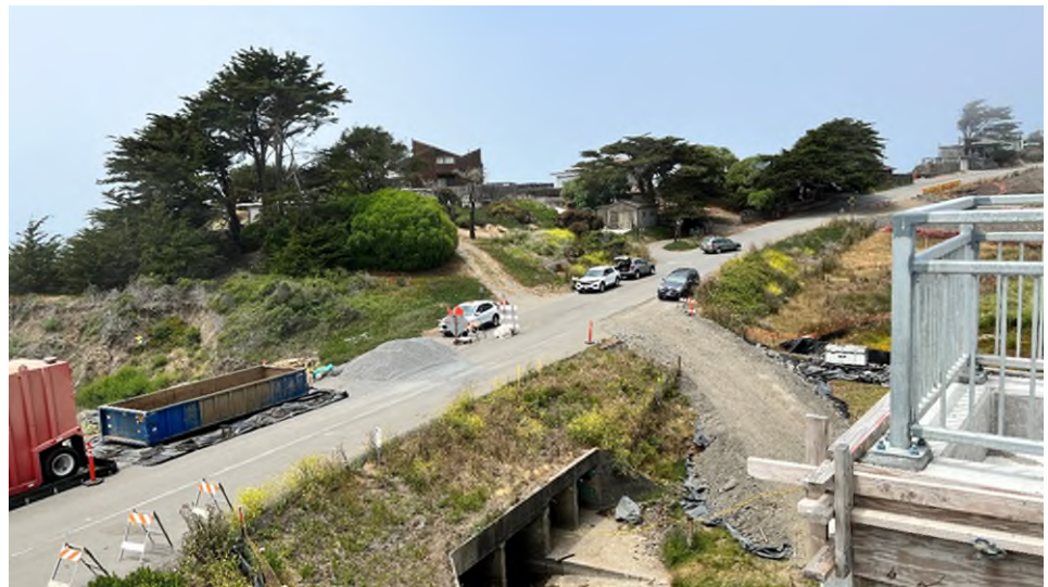
圖 48 Route 1 新建橋梁的前方受海岸侵蝕影響，圖中臨海的山崖已被海水侵蝕後退，數戶房子已掉入海中
