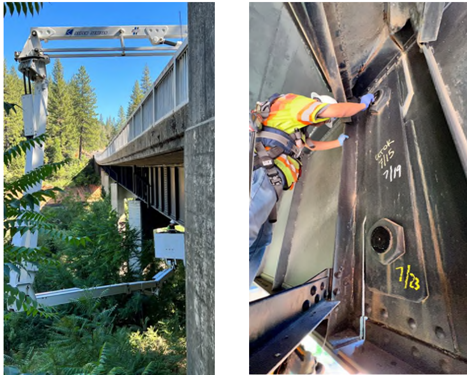
圖 71 Route 174 橋梁利用橋檢車進行 Fracture Critical Inspection，並以超音波儀器檢查 Fracture Critical Elements 的完整性
