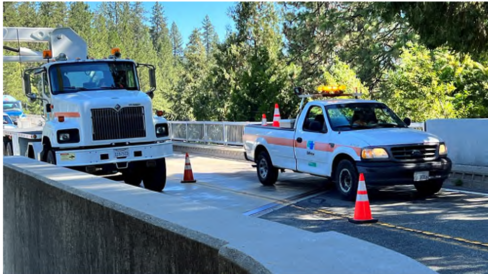
圖 70 Route 174 橋梁利用橋檢車進行 Fracture Critical Inspection，封閉 1 車道後僅餘 1 車道供雙向通行，交維工作極為重要，利用前導車引導車流確保安全
