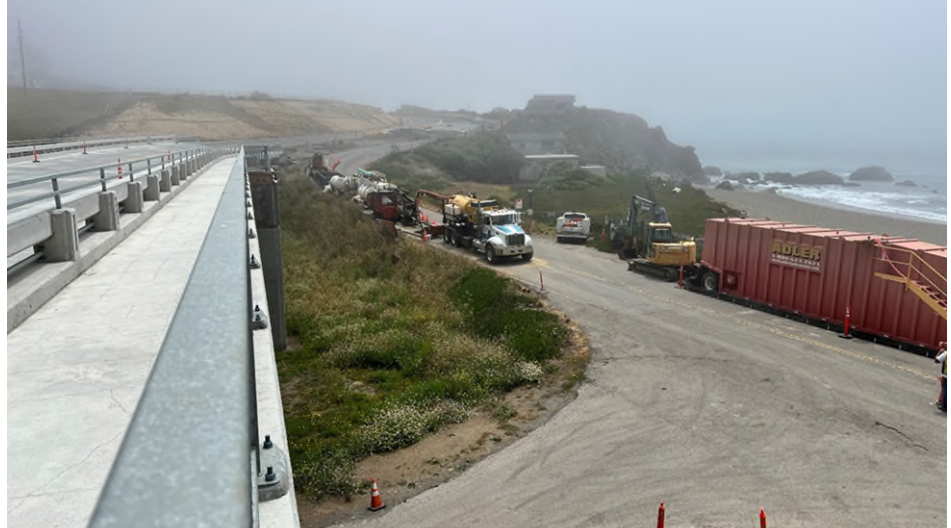
圖 47 Route 1 受海岸侵蝕影響，原路線飽受威脅，故更改路線往內陸移動並改為高架橋，花費 2500 萬美金
