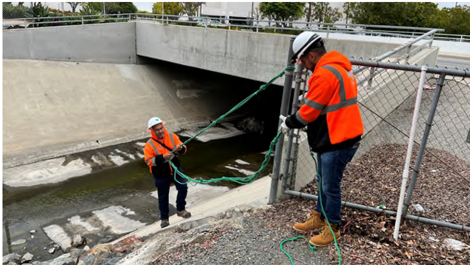
圖 68 跨越渠道橋梁，檢測人員固定繩索以類似垂降的方式下至渠道進行檢查
