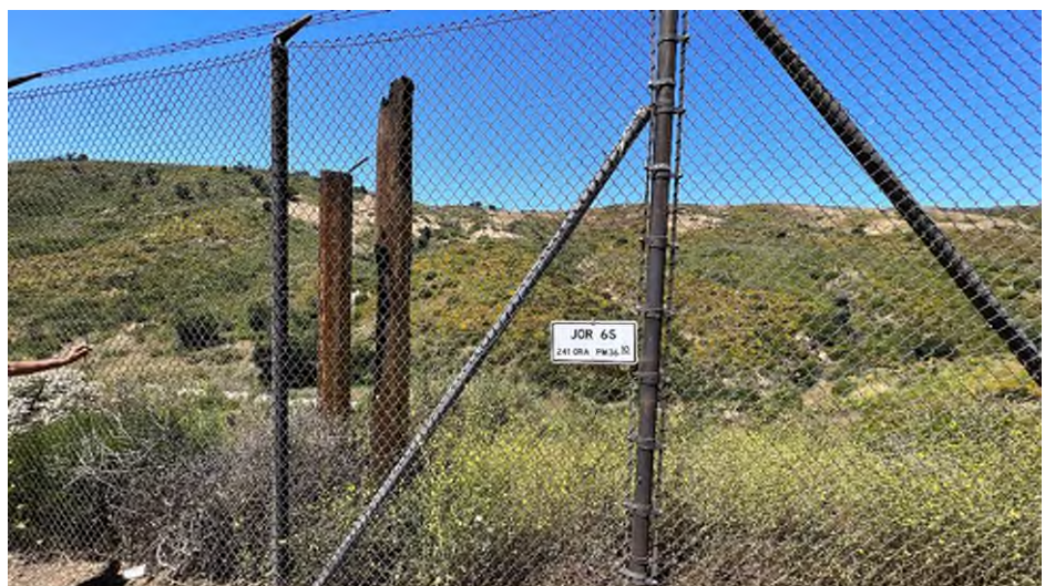
圖 44 Route 241 路側野生動物逃脫通道，原木構架支撐遭野火焚
