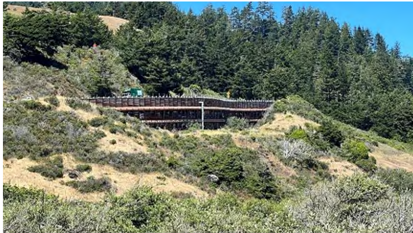
圖 17 主樁橫板條工法搭配地錨
