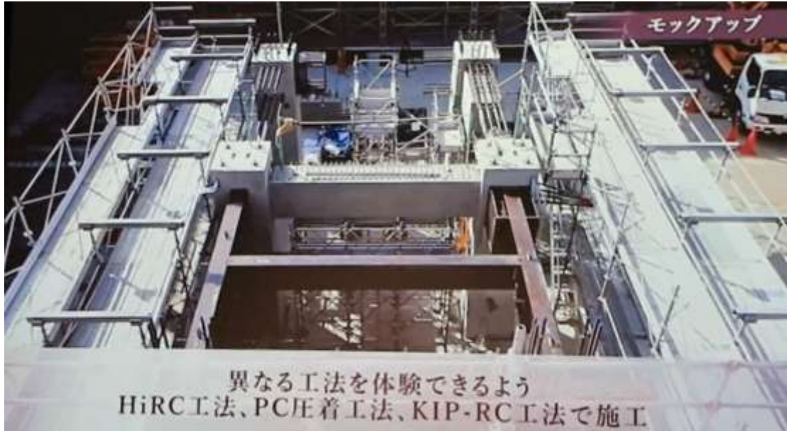
圖 85 鹿島技術中心各項異構工法（來源：經同意拍攝之簡報內容）
