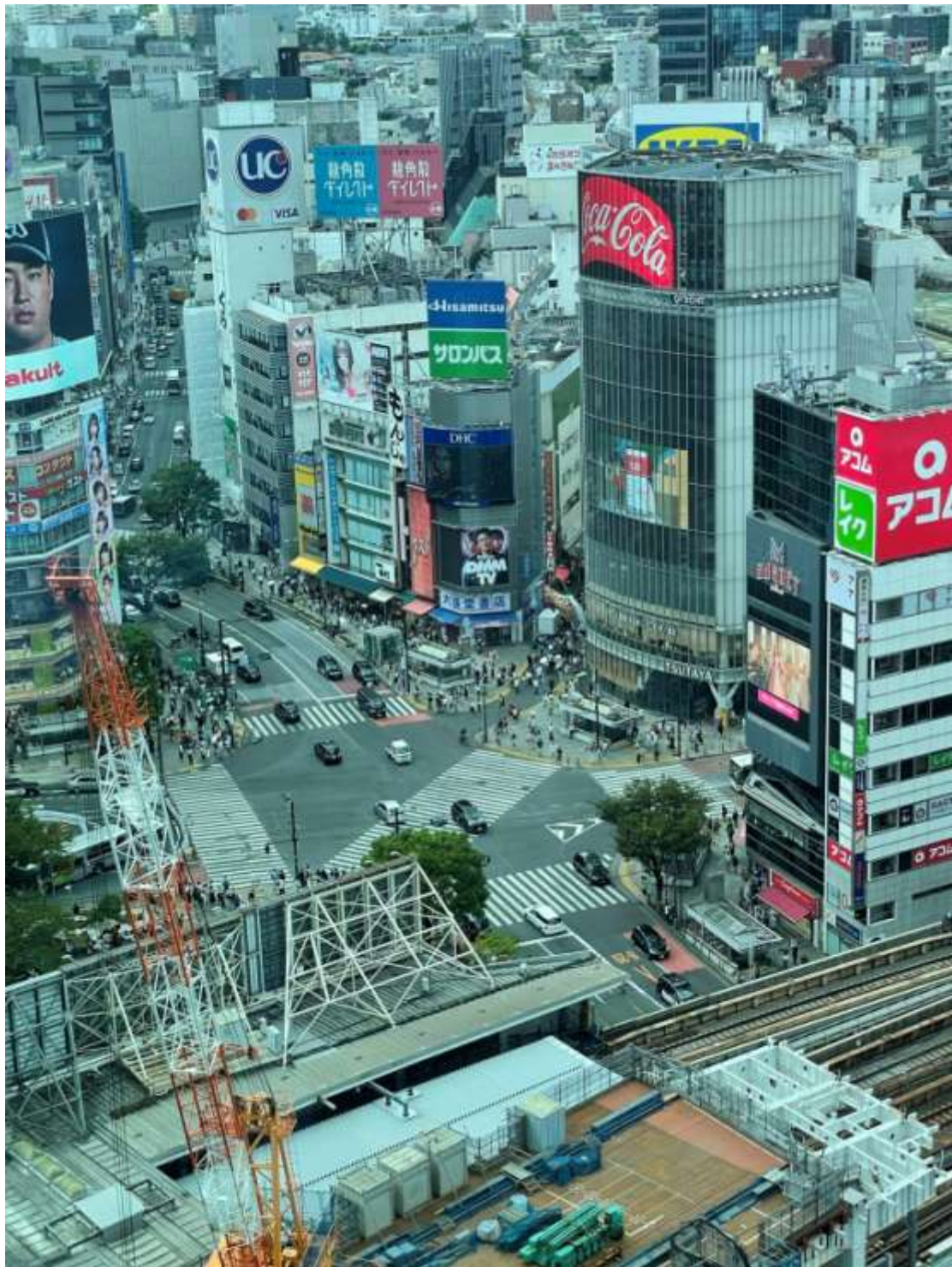
圖 104 澀谷站體增建工程（望向澀谷站前交岔路口）（來源：本計畫拍攝）
