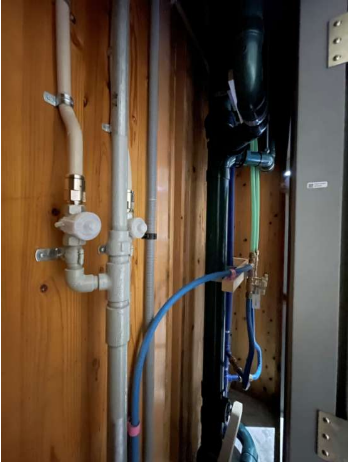
圖 89 鹿島技術中心飛箱工法宿舍管道間（來源：本計畫拍攝）
