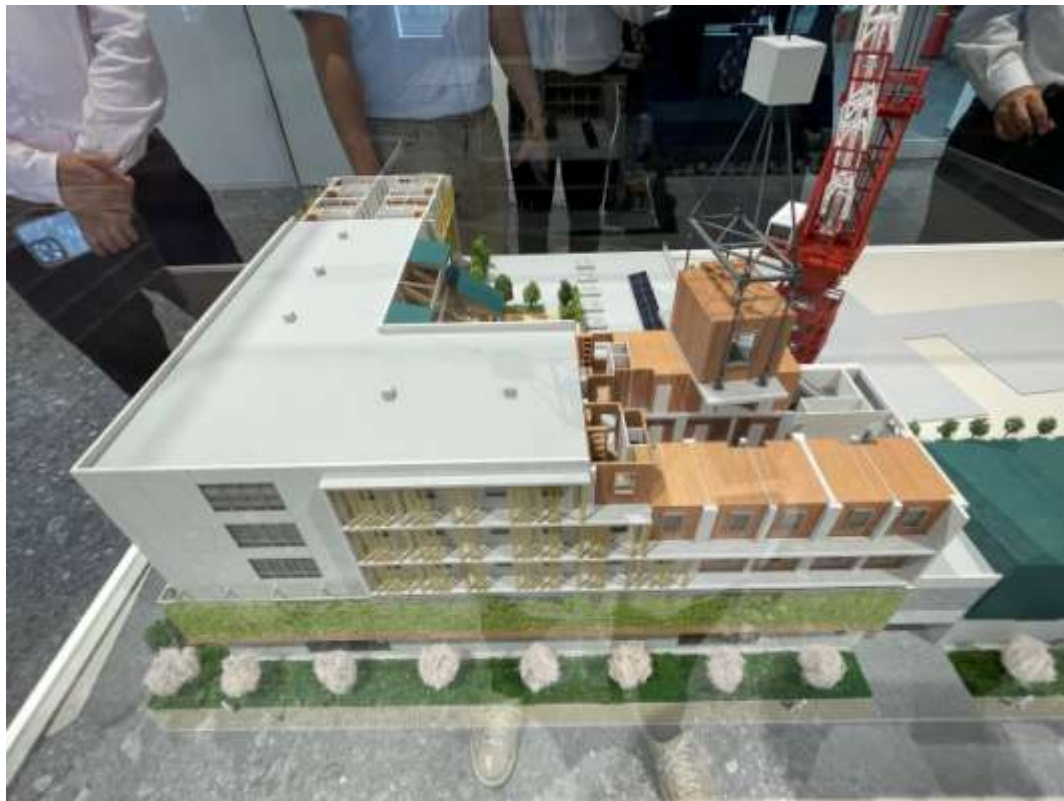
圖 87 鹿島技術中心飛箱工法施工模型（來源：本計畫拍攝）
