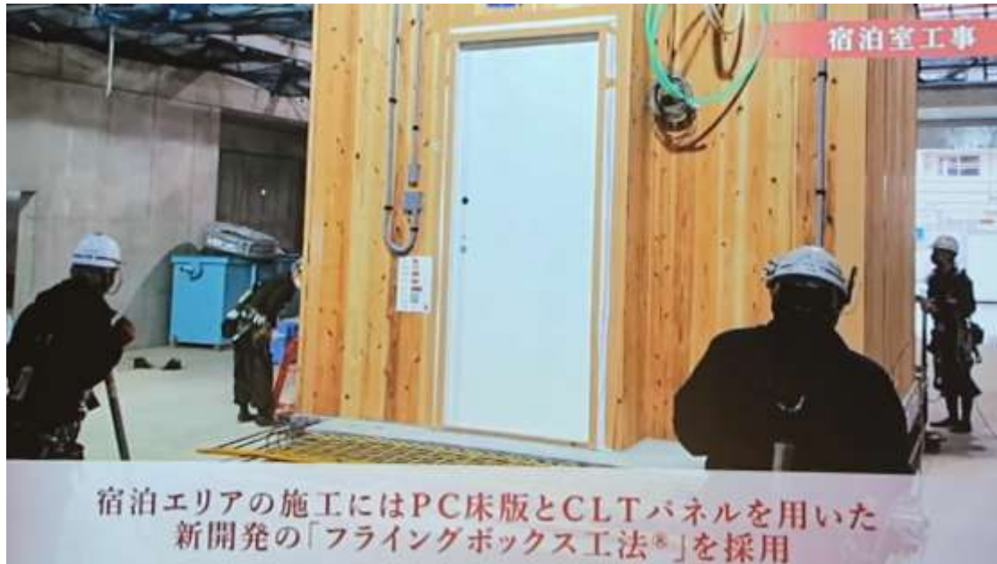
圖 86 鹿島技術中心飛箱工法（來源：經同意拍攝之簡報內容）
