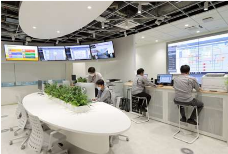
圖 25 ビルコムプラス中控中心（來源：竹中工務店網站）
