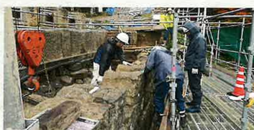
石垣積み直し作業の様子
