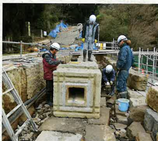
通水管の復旧
