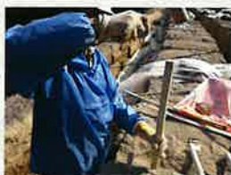
漆喰詰替作業
