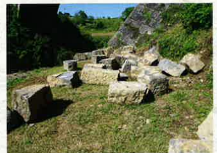
崩れた壁石垣の石材
