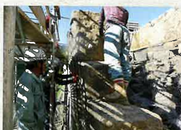
石垣積み直し(仮組み)
