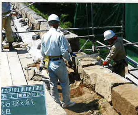
手摺石取外し状況(左岸上流側)
