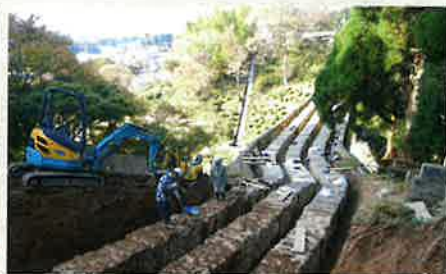
吹上口側の掘削状況
