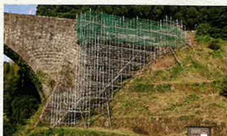
仮設足場設置状況
