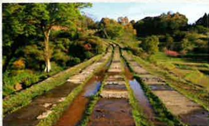
通潤橋上の漏水状況
