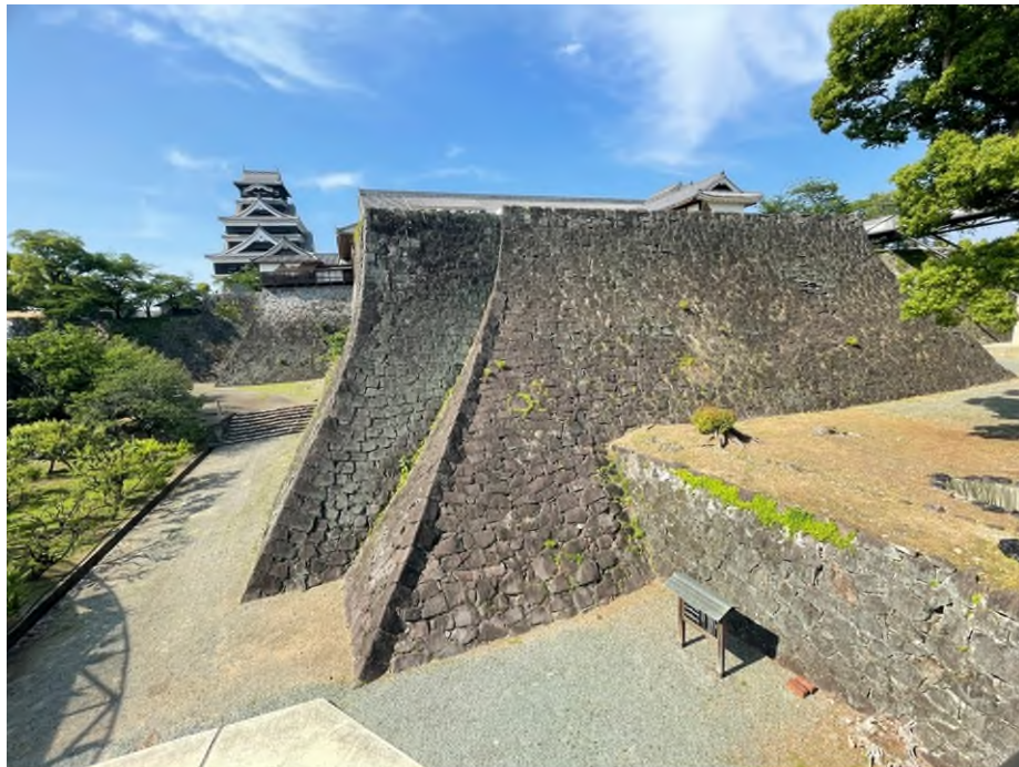
圖 2 熊本城的石垣大多底部坡度較平緩，到上部則近乎垂直，命名為「武者返し」，斜度極陡武士們無法攀爬，利於防守，
