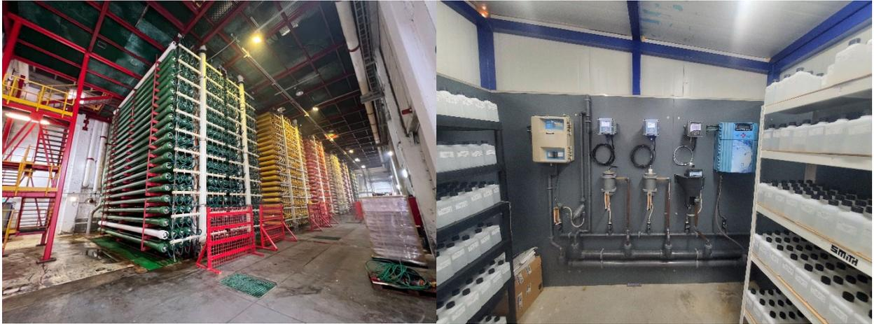
圖 3-1-5.Palmachim 海淡廠 RO 逆滲透機組與水質監測儀器及水樣保存室
