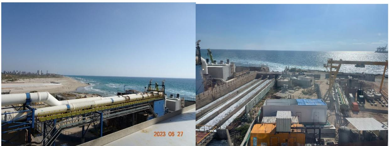
圖 3-3-4.Hadera 海淡廠取水管(左)與滷水排放(右，併入發電廠冷卻水排放渠中)
