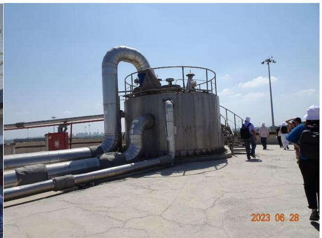
圖 3-4-3. Shafdan 污水處理廠厭氧消化槽(左)與其頂部之甲烷收集器(右)
