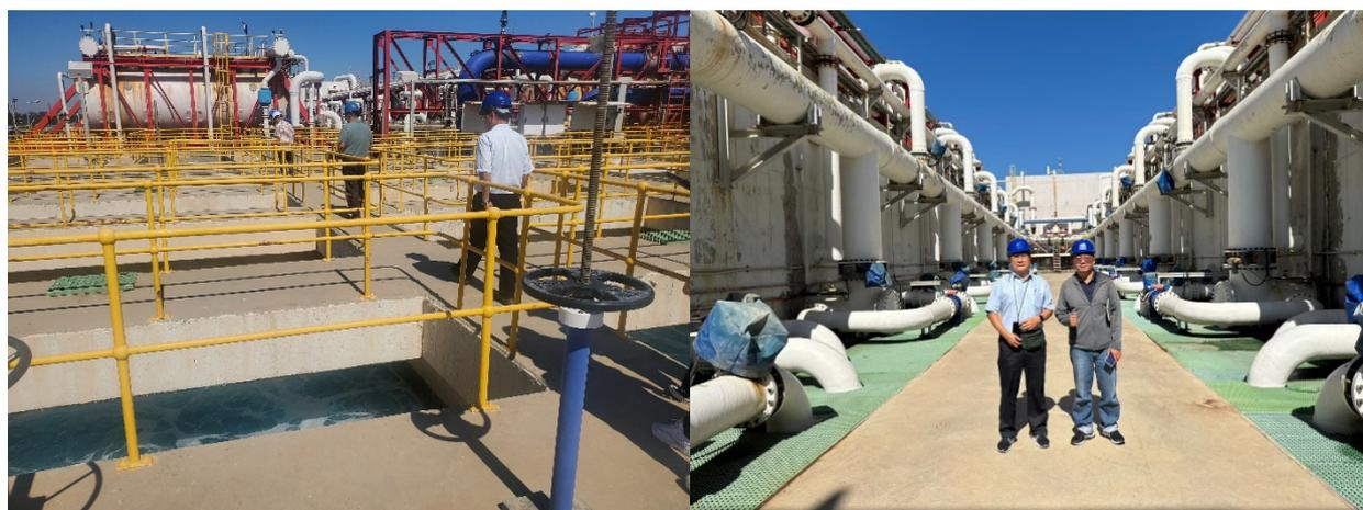
圖 3-1-4.Palmachim 海水淡化廠前處理濾池及前處理管廊
