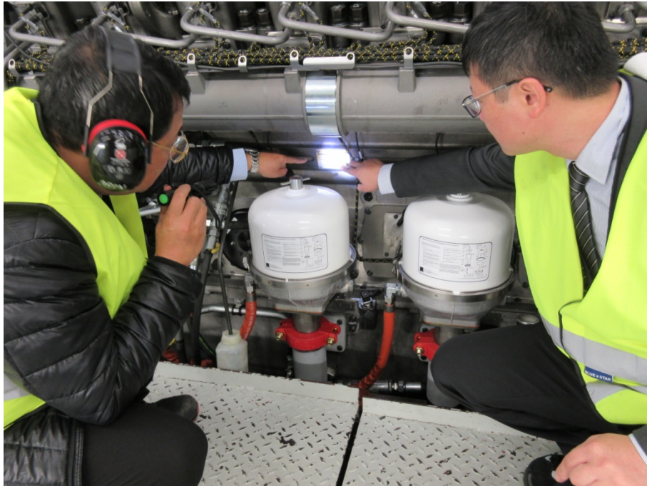
主機全負載時檢視是否有洩漏狀況
