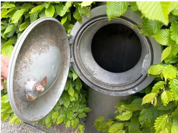
偵測到垃圾集滿，以真空抽吸將垃圾輸送到據500公尺左右的中央收集站再分類處理
