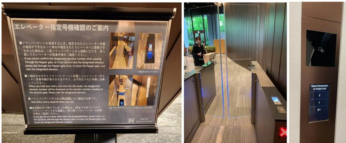
圖 2-4 電梯預先登錄系統之相關說明、閘門及電梯面板配置圖(參見第 36-37 頁說明)
