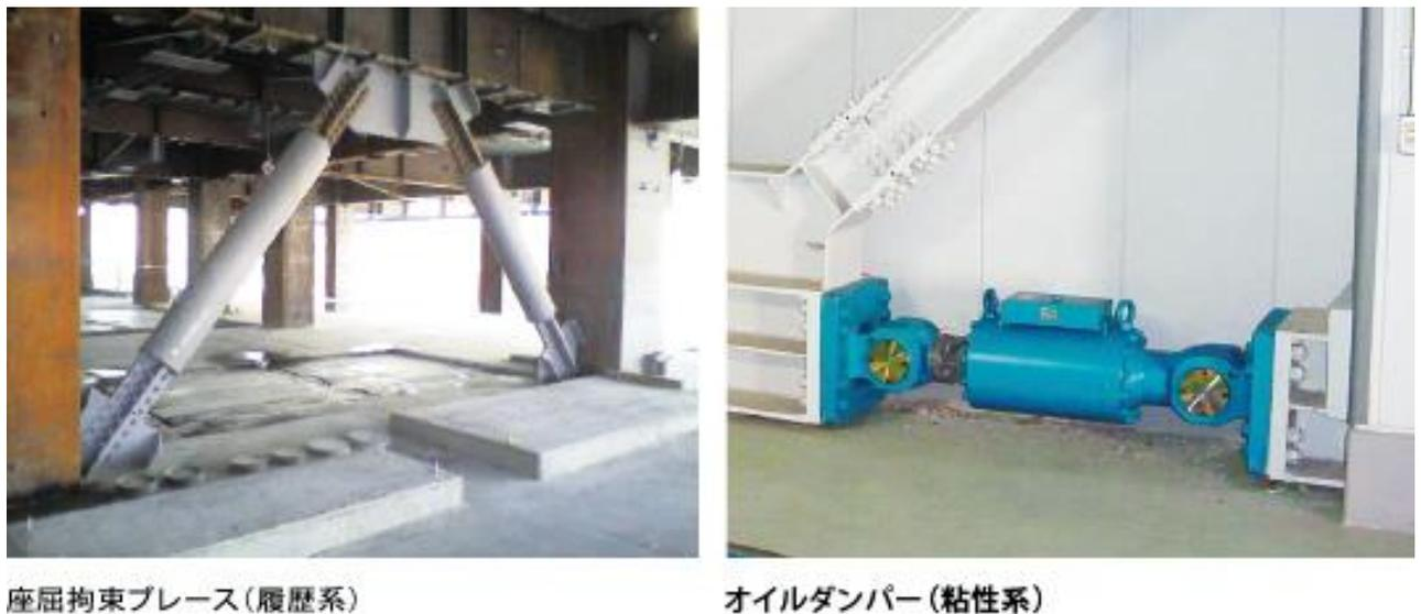
圖 13-5 抗震設備(斜撐阻尼器和油壓阻尼器)
