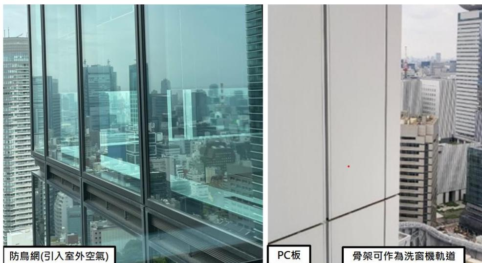
圖 2-7 窗戶防鳥網設計及外牆洗窗機軌道
