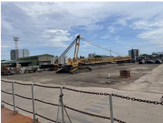
船邊欄杆狀況全已修復
