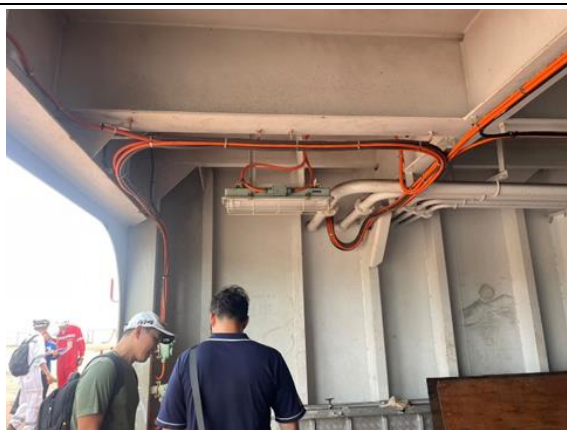
電線剪斷部分復原情形
