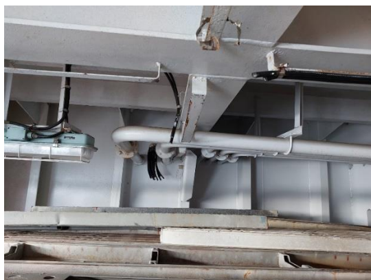
電線被海盜剪斷失竊
