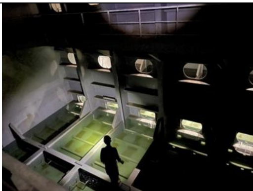
壓載水艙之間的走道檢查狀況
