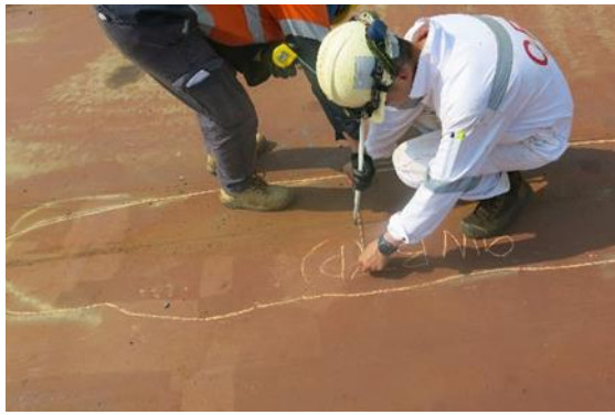
甲板上還是有幾處地板凹陷，拍照記錄此缺失告訴 EOS 改善
