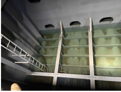
與驗船師下壓載水艙內檢查狀況
