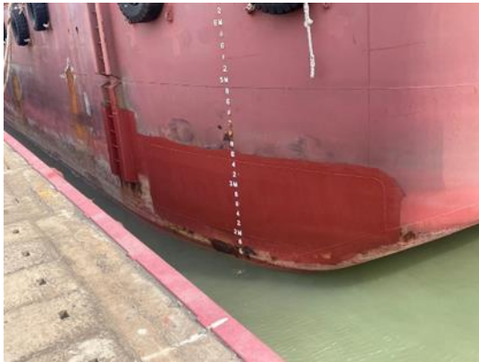
船艙右下凹陷變形船板修復狀況
