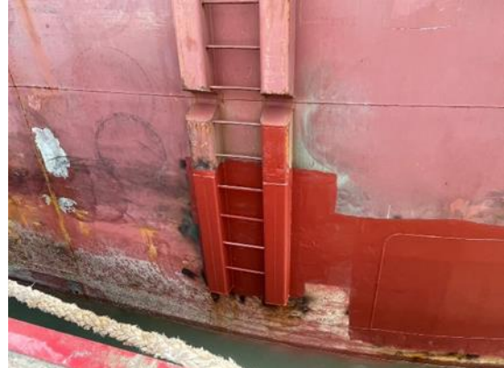
船艙右下側邊爬梯修復狀況
