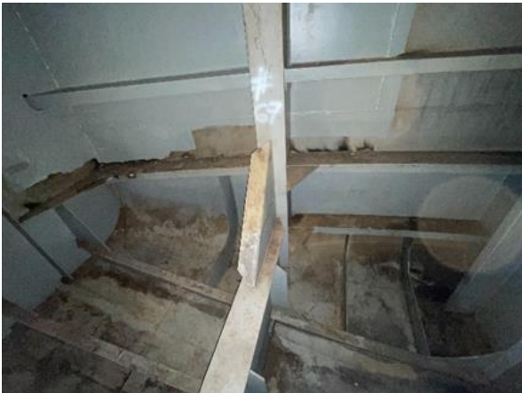
右船艙內部 1WBT 壓艙水艙肋骨變形凹陷已修復情況
