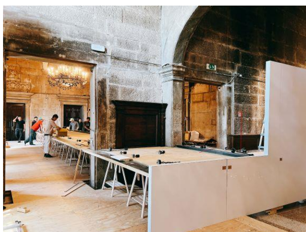
▲燈具安裝施作
