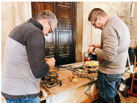
▲ 本館聘任威尼斯當地廠商電力供電線路施作
