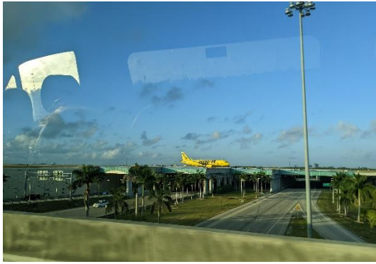
圖 11、機場不敷使用新機場直接加蓋在原有公路上方
