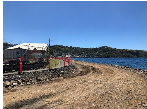
圖 159、港口施工現場
