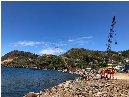
圖 158、港口施工現場
