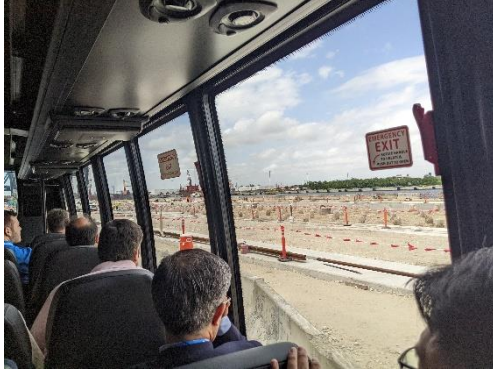
圖 92、櫃場正在進行橋式機地基工程
