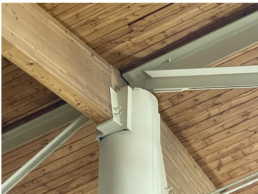
圖 59 鋼柱與木梁接合細部
