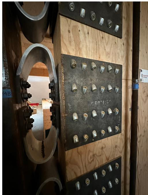
圖 12 木構建築消能裝置細部
