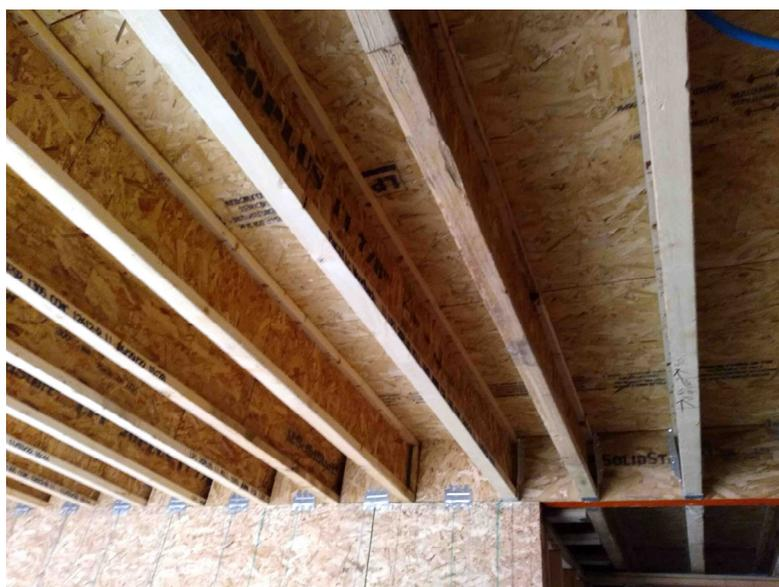
圖 31 木造 I 型小梁(Joist)
