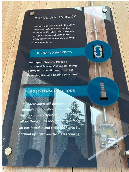
圖 15 木構建築消能裝置解說牌
