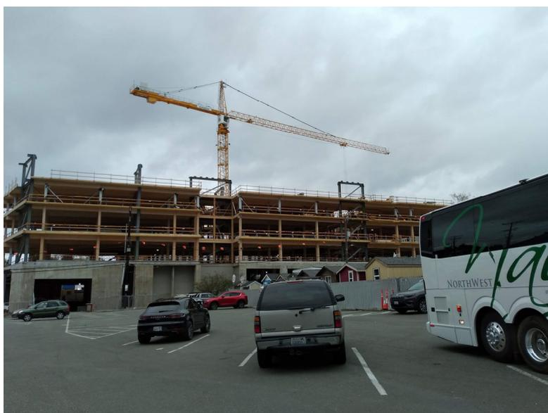
圖 30 Rainer 建案外觀(下 2 層 RC 造+上 5 層木造)
