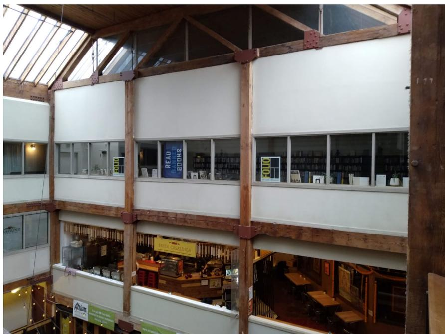
圖 51 派克市場木構造梁柱構架
