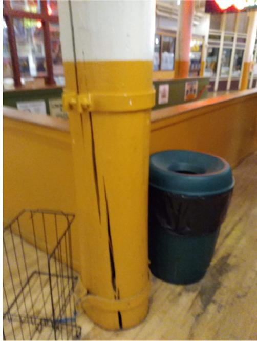
圖 52 派克市場木構柱補強
