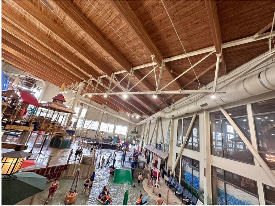
圖 60 大跨度木梁搭配金屬桁架
