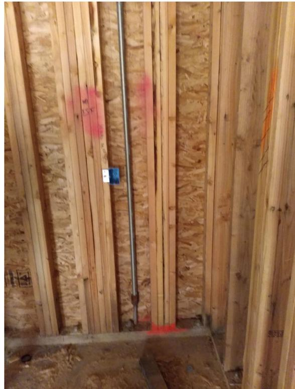
圖 33 木造建築物預埋調整螺桿
