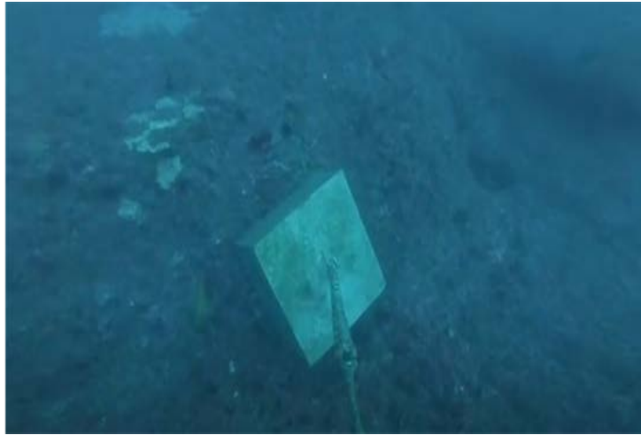
圖 3.19 本所於安平港及布袋港-浮球錨繫重塊
