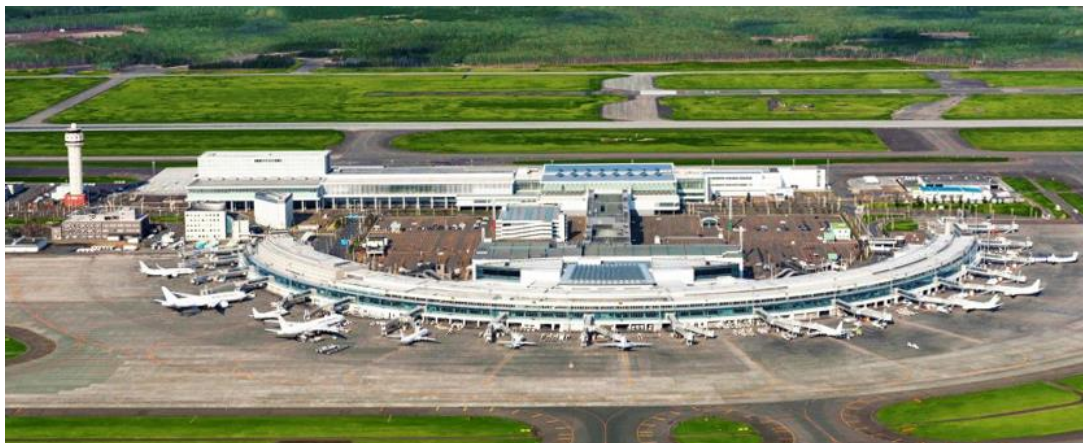
圖 3.1 新千歲機場(含擴建工程)空照圖
