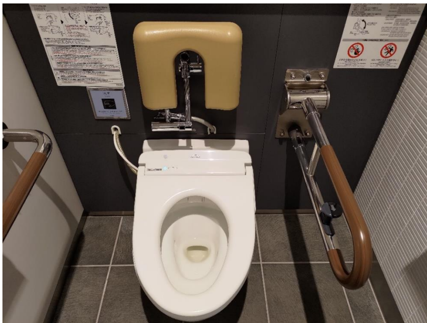
圖 4.3.3 無障礙廁所的防護措施不會感到冰冷
