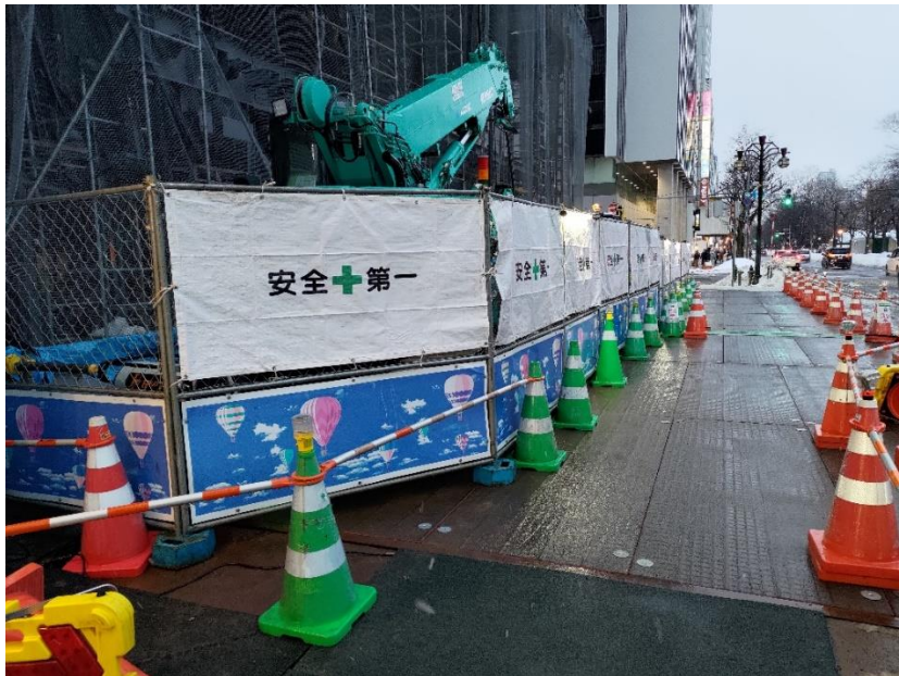
圖 4.4.39 建築工地人行道防護確實
