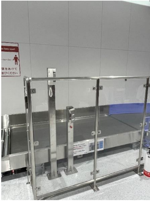
圖 4.2.12 工作人員作業區護欄
