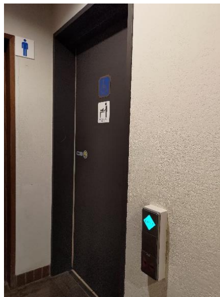
圖 4.4.4 多功能廁所按鍵自動門
