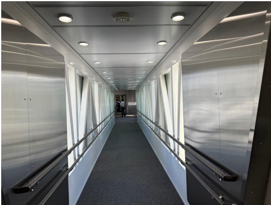
圖 4.2.26 國際線空橋設施
