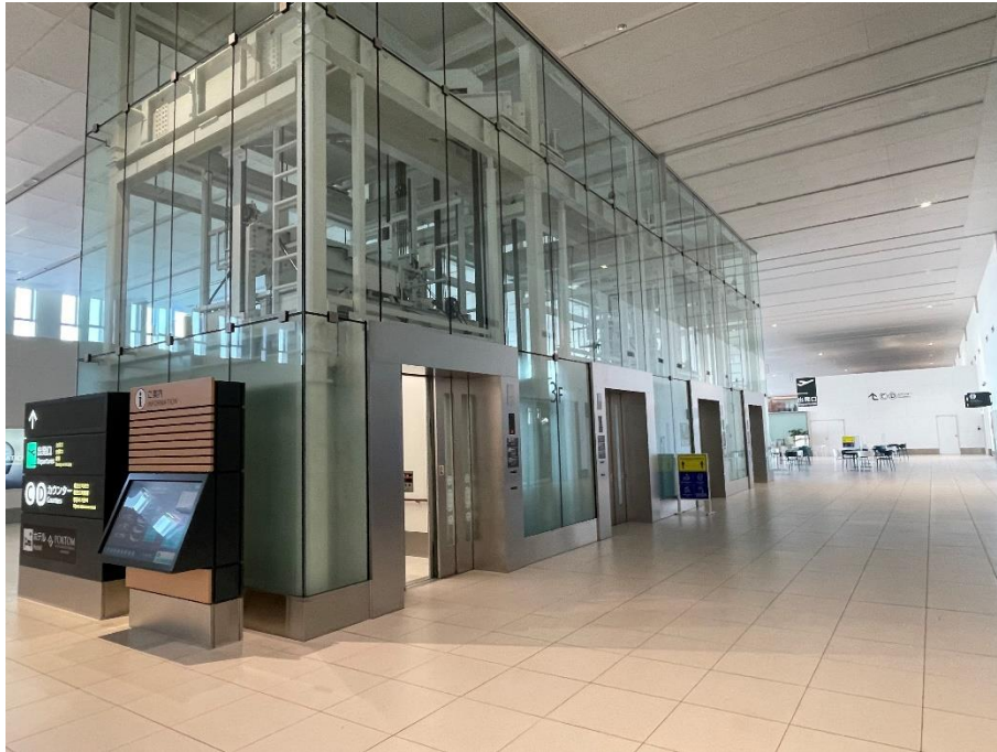
圖 4.3.12 擴建新設的電梯相當寬敞且帶後現代主義的設計風格
