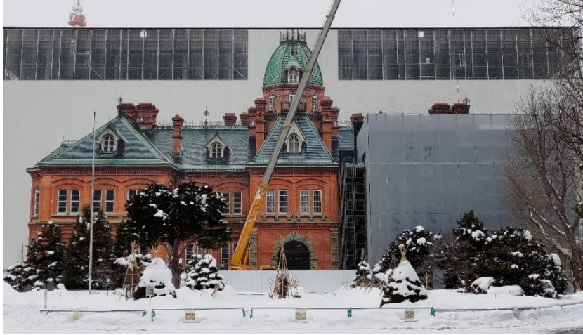
圖 4.4.38 北海道舊本廳舍外牆整修施工中
