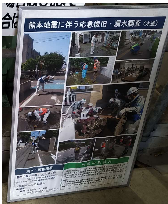
圖54 熊本地震相關的應急復舊與漏水調查作業
