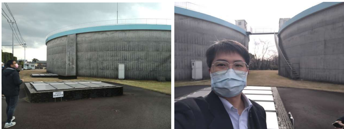
圖55 配水池現地照片
