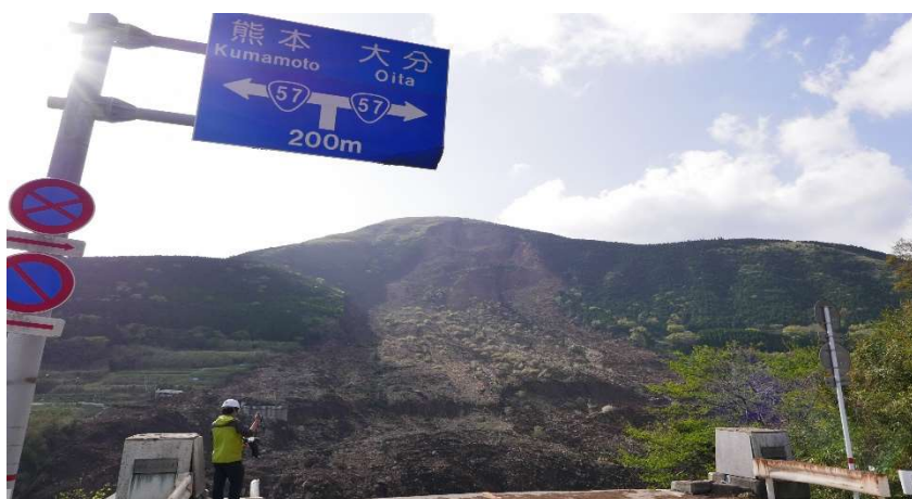
圖41 2016 年熊本地震倒塌後的阿蘇大橋遺址
