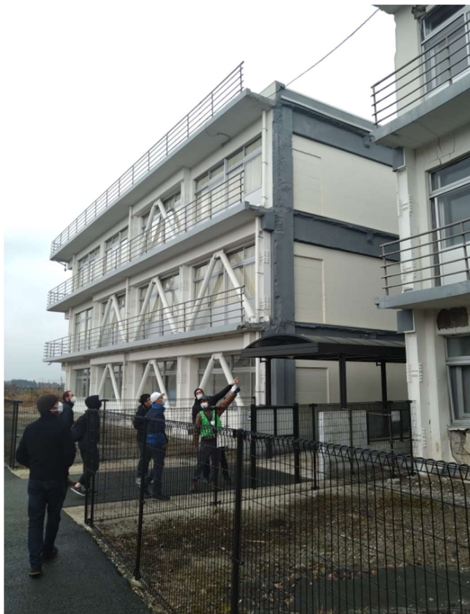
圖39 大學阿蘇校舎 1 號館西側耐震補強結構
