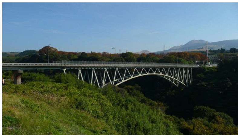
圖40 2016 年熊本地震倒塌前的阿蘇大橋
