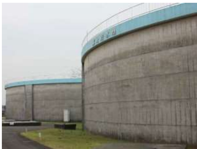
圖87 具有抗震結構的蓄水設施
