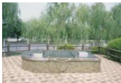
取水井内部取水井外觀
