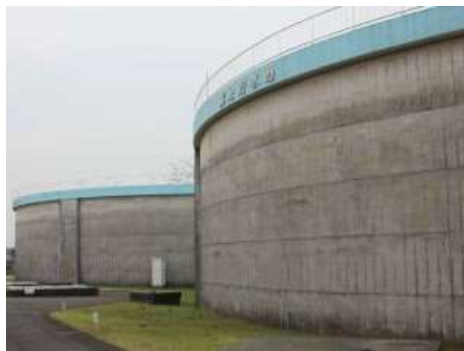
圖90 熊本市健軍有兩個配水池
