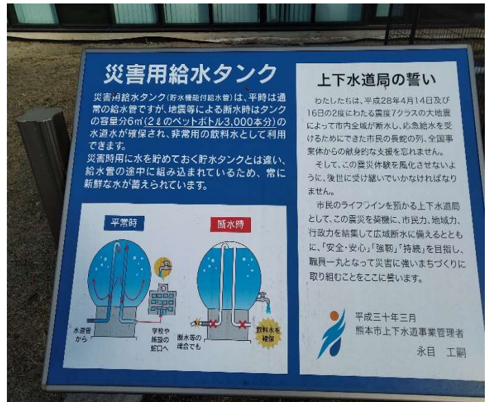
圖64 貯水機能付給水管説明看板
