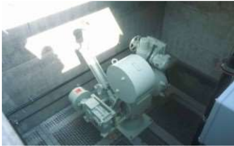
圖91 健軍在水池之間安裝緊急遮斷閥
