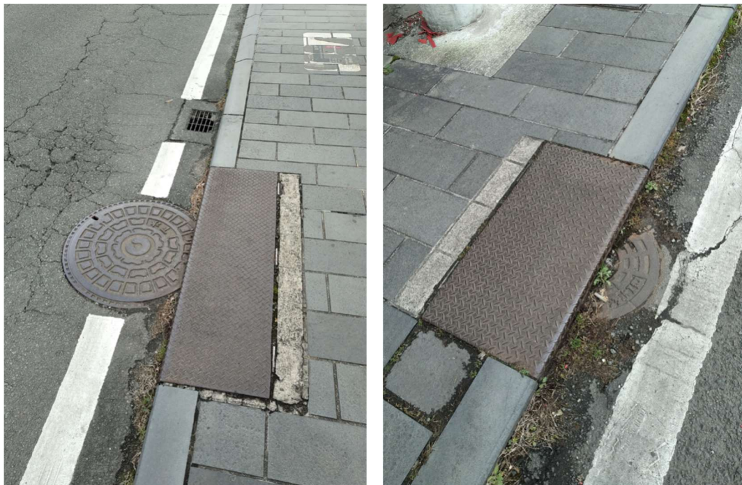
圖69 與人行道共構的設置方式
