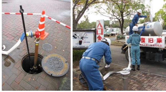
圖85 使用消防栓向臨時供水站給水
