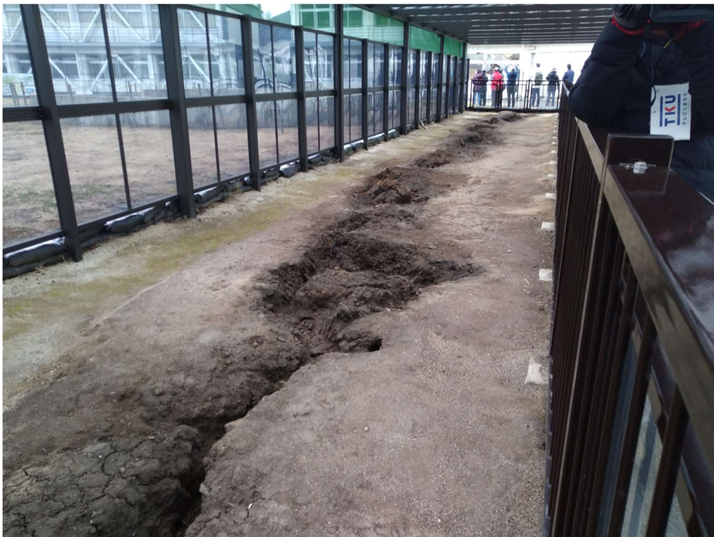
圖35 斷層位移造成地面裂痕
