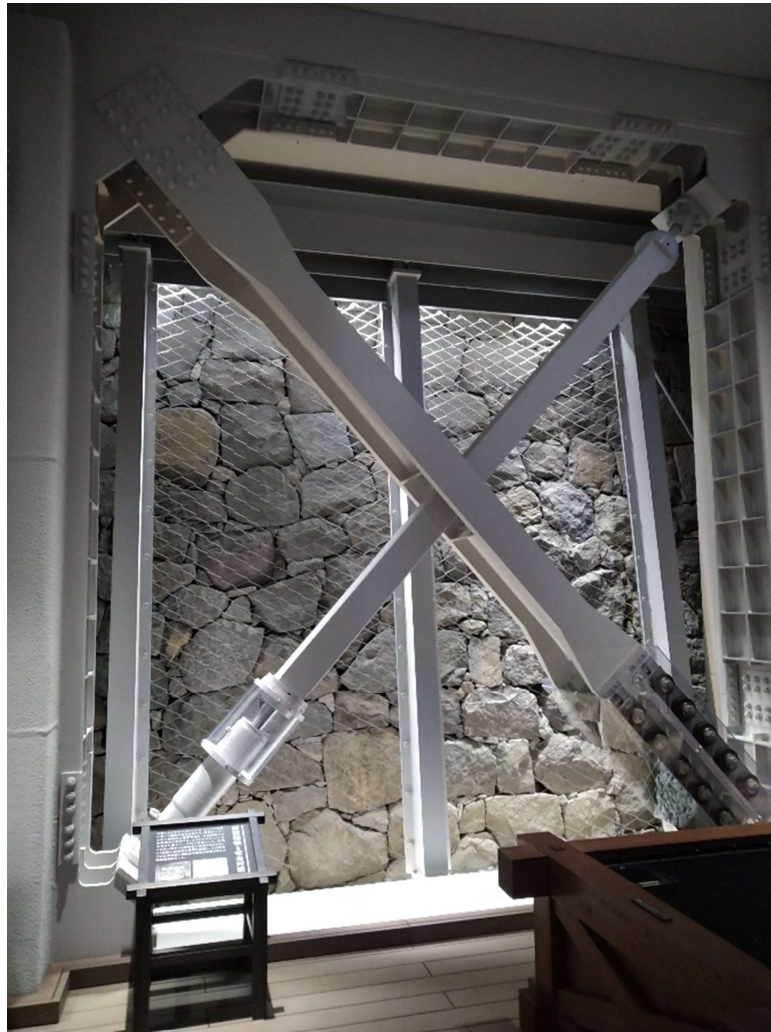
圖31 熊本城天守閣耐震補強的な安全措施
