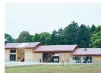
栗源第一薪炭供給所
