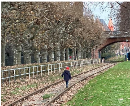
鐵軌旁無相關阻隔措施
