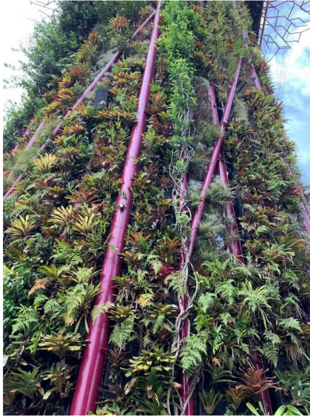
圖十五、濱海灣植物園 Super tree 上的攀附植物近景，以植穴固定、拉設澆灌管線等方式，克服空中乾燥與水分劇烈變化的問題，提供植物較佳的生長環境
