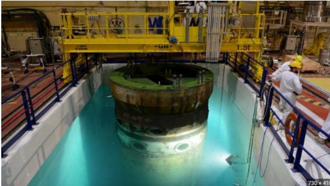
圖十六、斯洛伐克 Bohunice V1 反應器壓力容器吊運至溼式切割水槽
