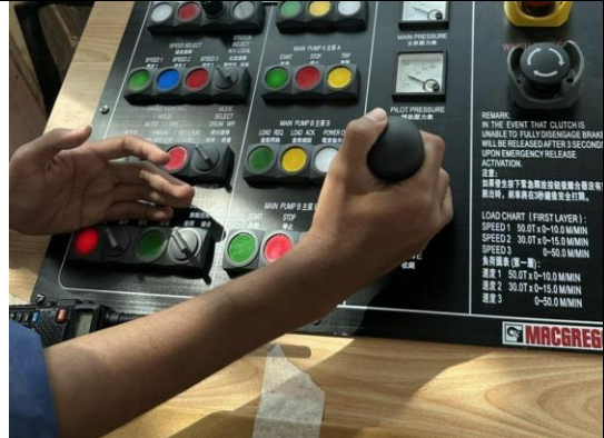
錨機與絞機測試
