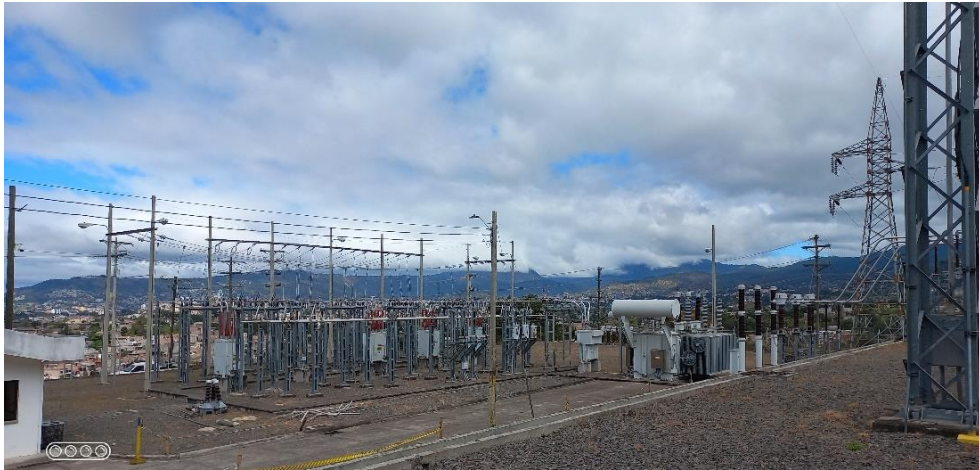
圖 64 線路經避雷器後經一台配電變壓器降壓為 13.8kV 送配電開關場
