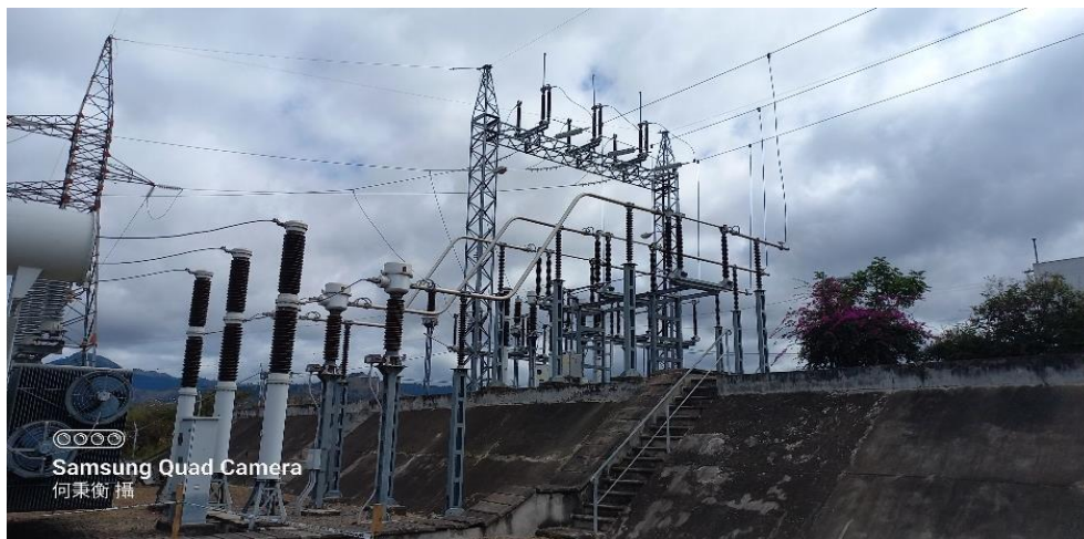
圖 63 經 B530 匯流排以一回線 T 接引入
