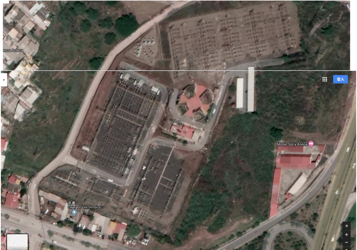
圖 54 SuYaPa (SUY) 超高壓變電所空照圖 (圖右上側為 230kV 開關場、左側為 138kV 開關場、 左下側為 13.8kV 開關場、右下側為 69kV 開關場)
