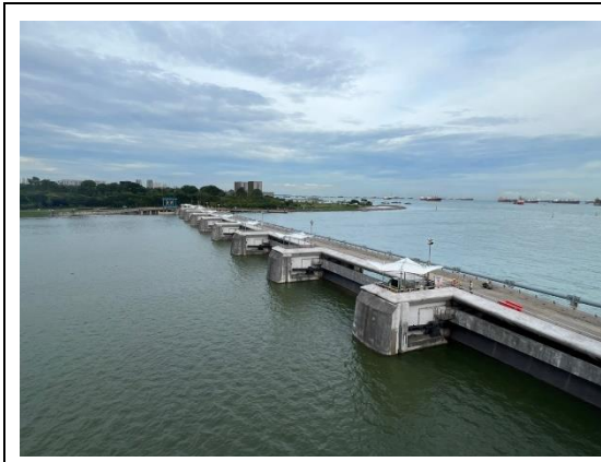
圖 19、Marina Barrage 防潮閘門
