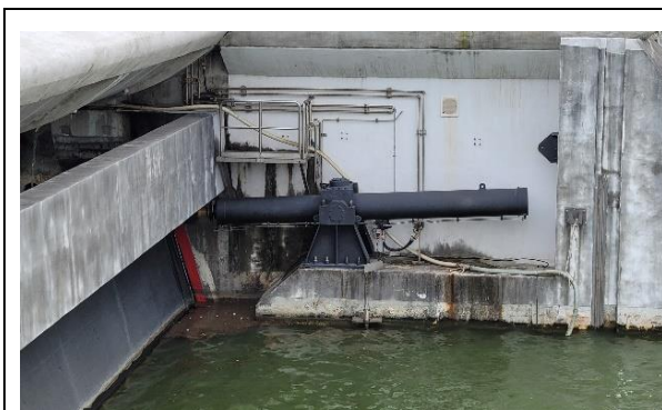
圖 21、冠型閘門控制機關
