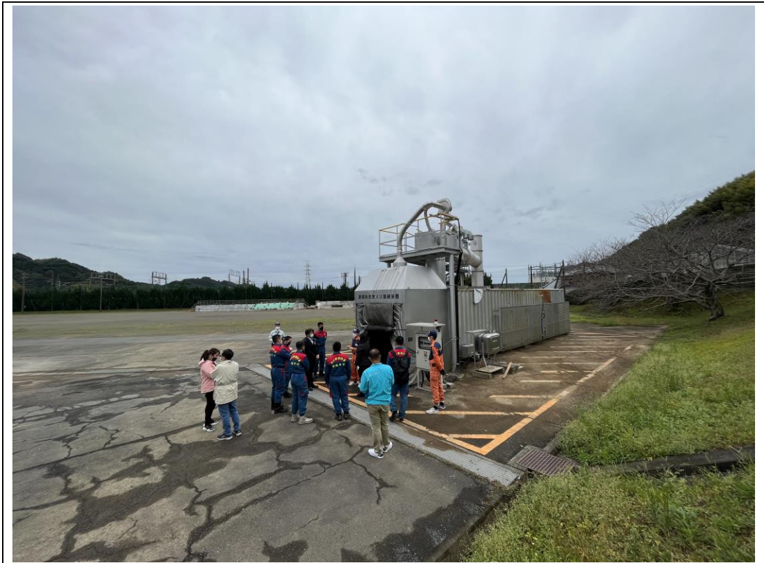
圖 3.3.4 靜岡縣消防學校燃燒櫃設施。
