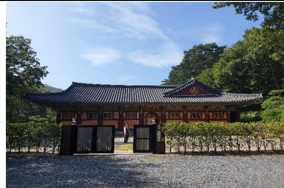
圖 18：通度寺供其他寺院來訪僧人掛單 的宿舍，寺院寄宿相關設施仍維持傳統建 築形式。
