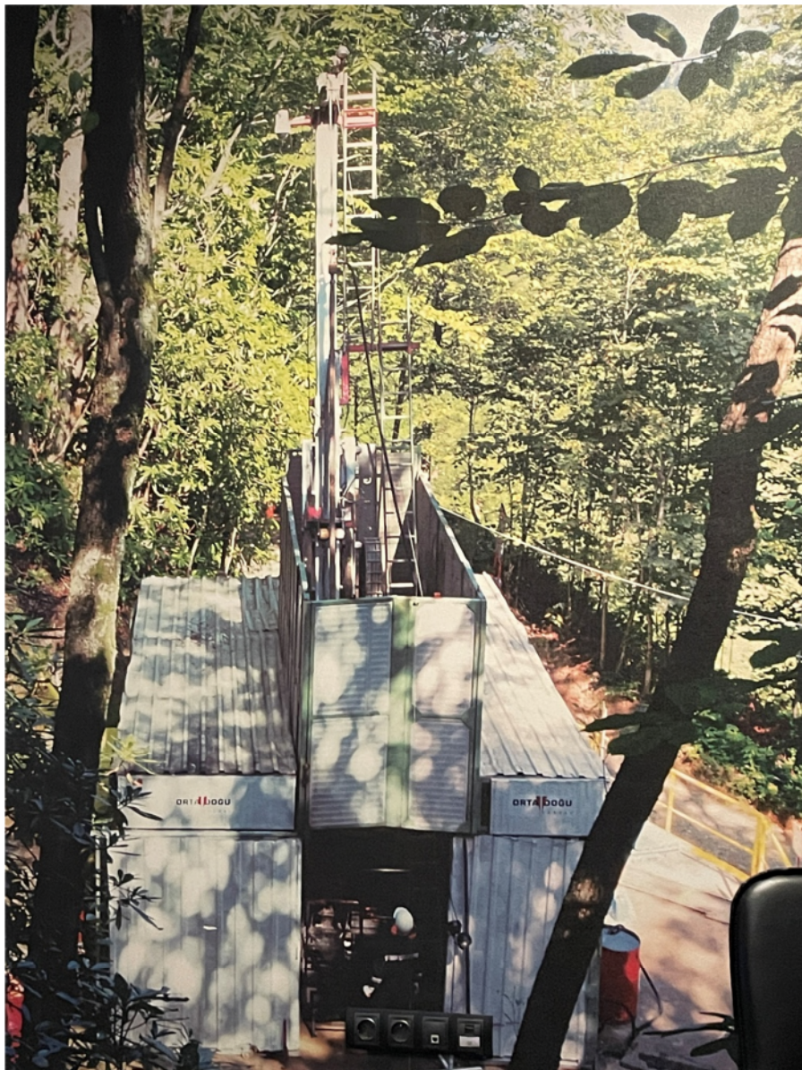
圖 6. 鑽機外圍加上簾幕阻絕噪音
