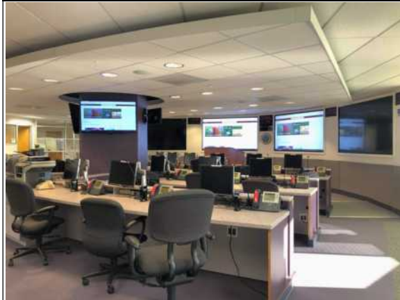
圖三、APHIS 緊急防控會議室：配有大型液晶、不斷電系統、各座位配備電腦、電話等。
