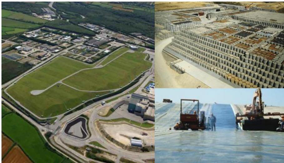
圖二十五 法國低放處置場 CSM 覆蓋系統設計施工
