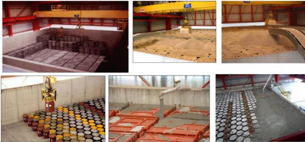
圖二十二 處置窖填充作業示意圖
