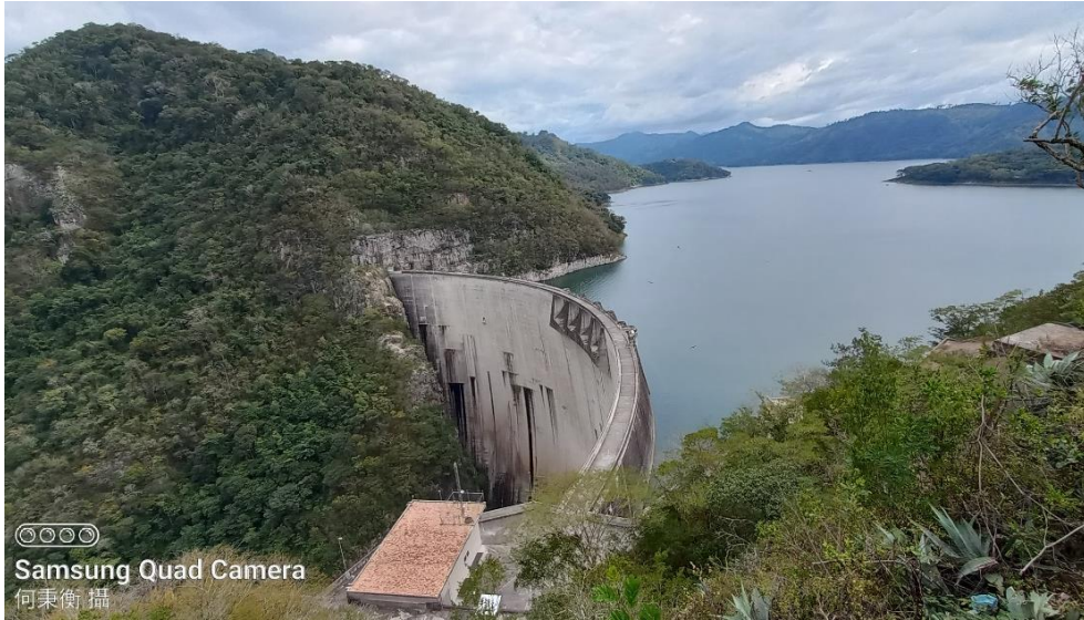
圖 105 El Cajón 水壩之二
