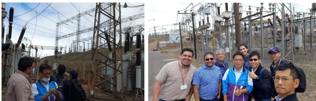
圖 88 宏電 SuYaPa (SUY) 超高壓變電所現地參訪
