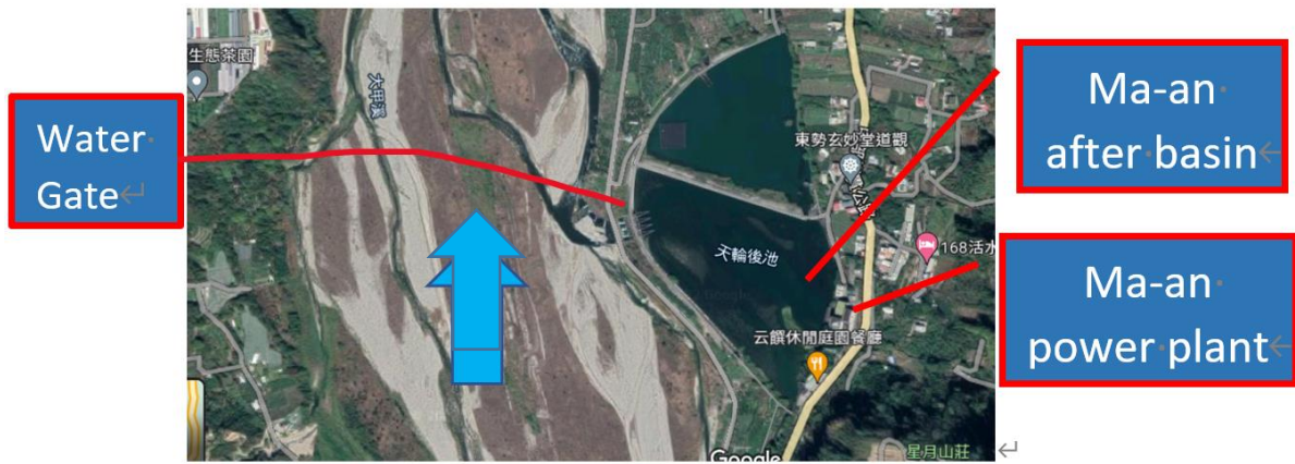
圖 131 發電廠尾水出口建置後池圖
