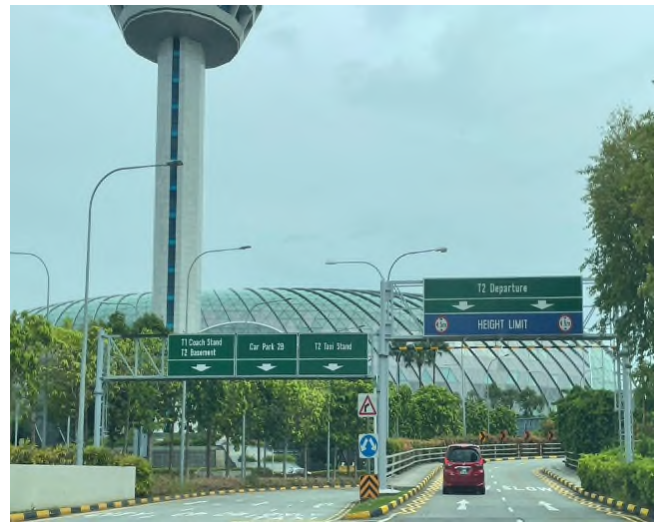
2.1 前往航廈道路之路標及限高標誌
