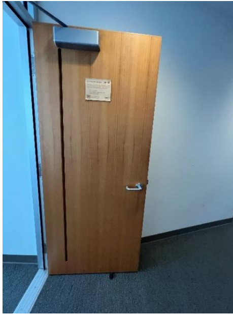
圖 12、13：CIRS 木門正、反面簍空通風設計
