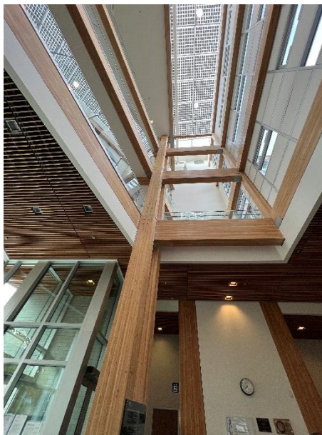
圖 9：CIRS 建築結構大量採用木材
