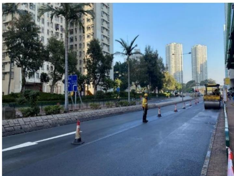
圖 14 低噪音路面材料施工
