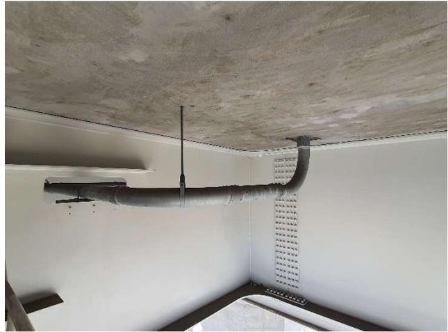
圖 60 橋面排水管穿過鋼樑
