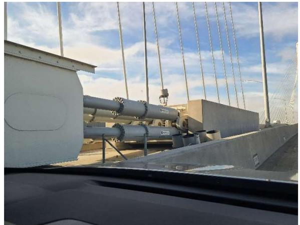
圖 54 設置於橋面版上的縱向阻尼器
