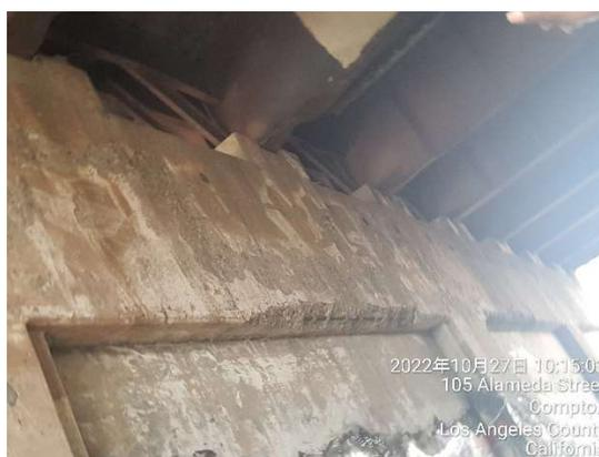
圖 14 混凝土受高溫影響已剝脫，肉眼可見鋼筋
