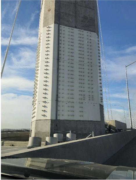
圖 42 斜張橋主塔防恐保護鋼板，設計原則及承受攻擊耐受度為機密。
