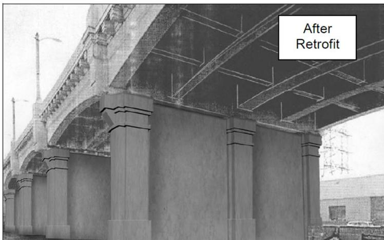
圖 24 橋柱補強規劃，下圖為補強後示意圖。但實際未採此方案，而係拆除重建<sup>19</sup>。
