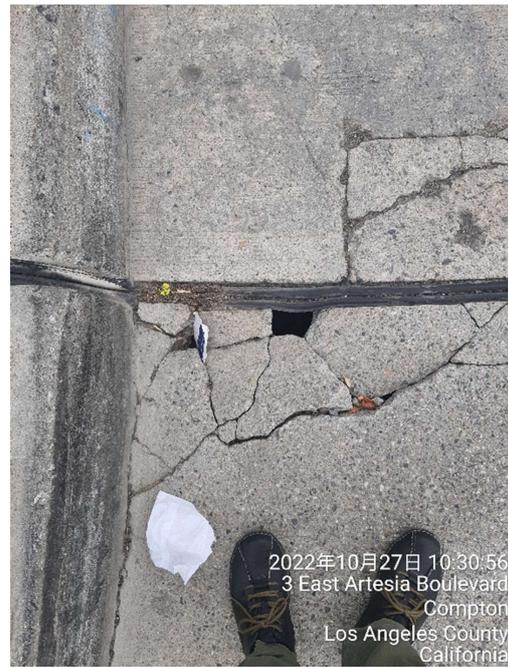
圖 20 坑洞約一個拳頭大小、已貫穿橋面版
