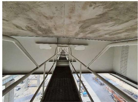
圖 41 鋼橋下方，橋梁檢測用人行步道
