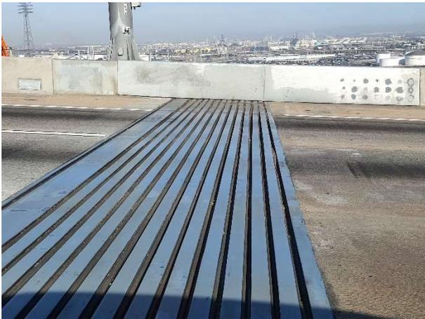
圖 44 鋼橋與引道橋混凝土箱型梁間之伸縮縫
