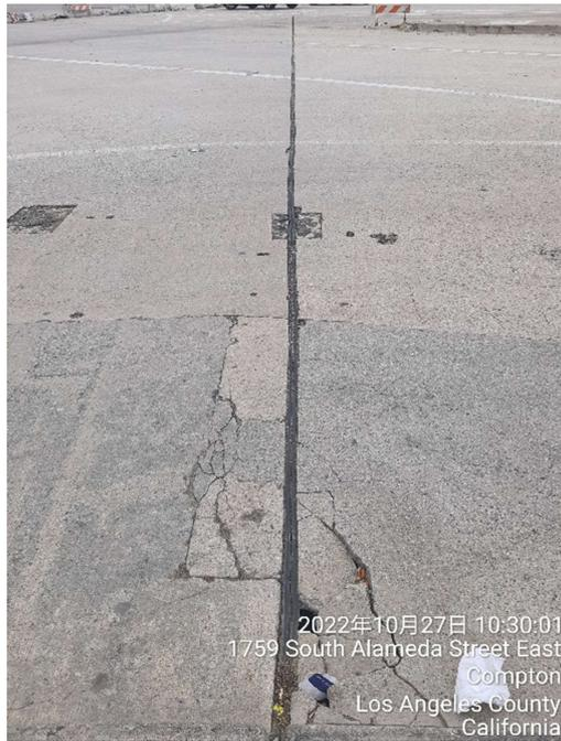
圖 19 橋面版有明顯裂縫及坑洞
