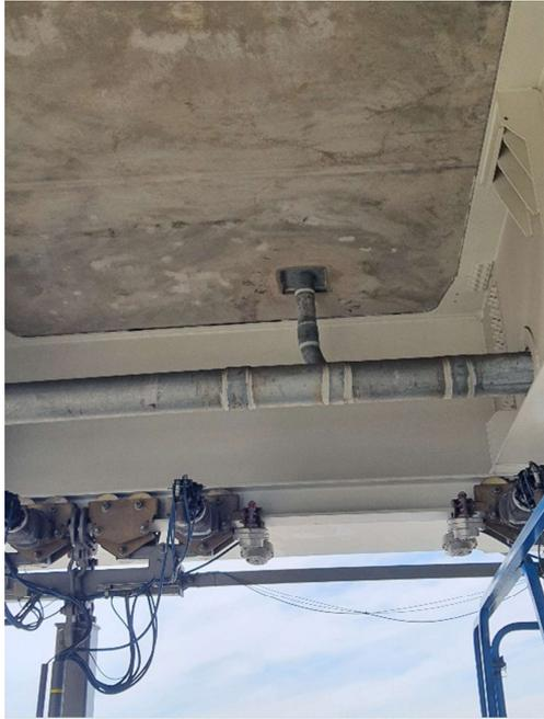
圖 59 橋面版下附掛之排水管，採用銲接鋼管
