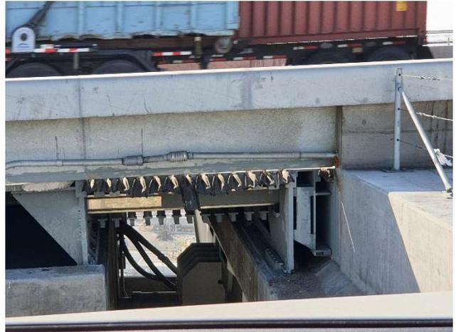
圖 45 鋼橋與引道橋混凝土箱型梁間之伸縮縫側視圖
