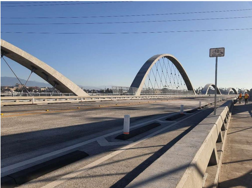
圖 30 新建第六街高架橋配置有汽車、自行車、人行道、圍籬。圍籬高度視下方受保護
