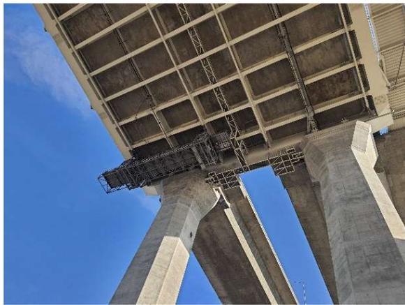
圖 40 鋼橋檢修工作車
