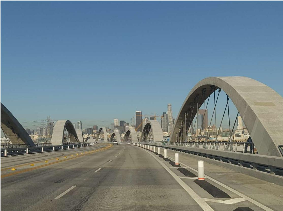
圖 35 第六街大橋遠眺市區。橡膠墊右側為自行車道，完工後遭民眾批評不夠安全，快速行駛之車輛如有不慎跨越車道，仍有可能衝撞自行車。
