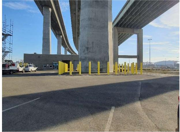
圖 43 保護橋墩用之鋼柱
