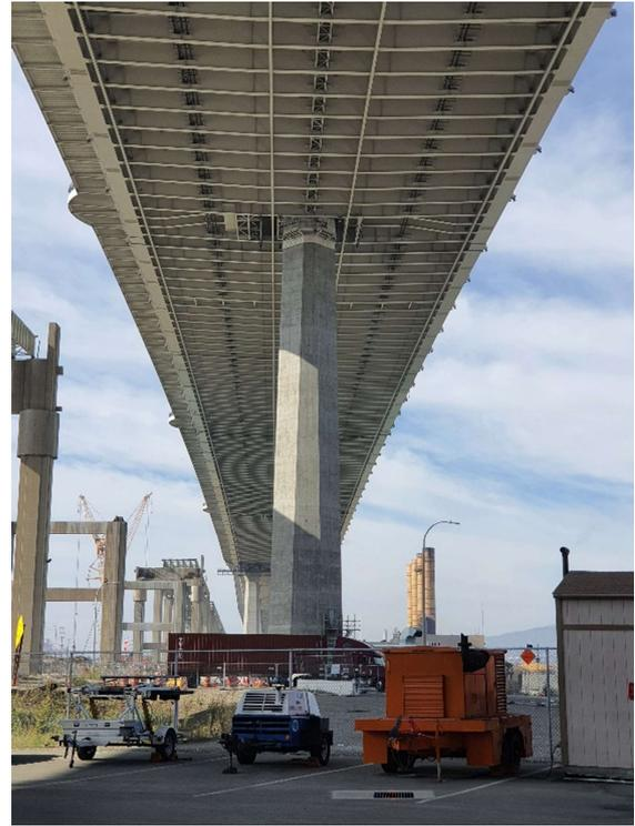
圖 51 斜張橋橋塔採下寬上窄、八角型設計
