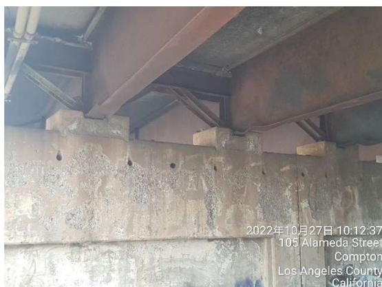
圖 13 鋼 I 型梁受火害高溫影響，腹版、翼版變形
