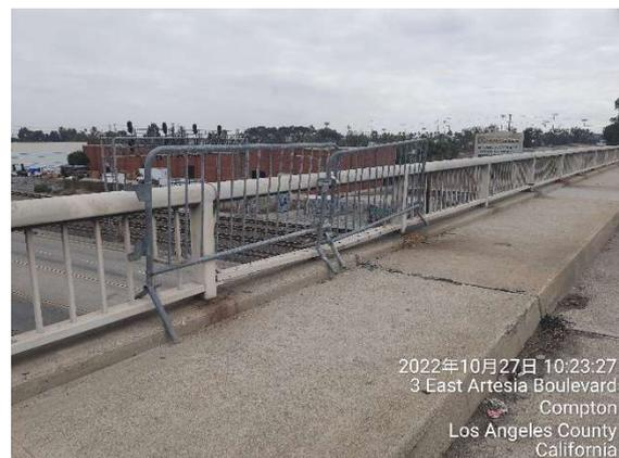
圖 18 護欄缺口以不同型式欄杆補強，僅以鐵線固定，易遭竊取破壞
