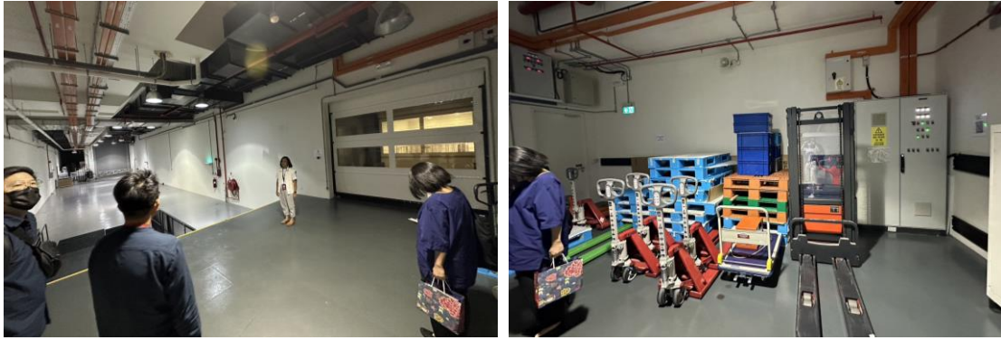
(左)卸貨區全景，(右)卸貨工具收納整齊
