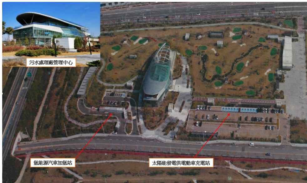
圖 2-3 東灘 2 污水處理廠鳥瞰圖
