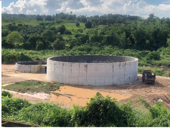
預混槽與厭氧槽
