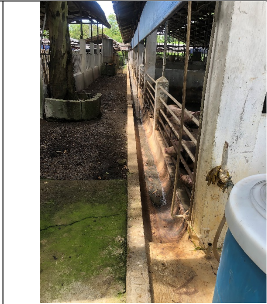
豬廁所排放之糞尿溝
