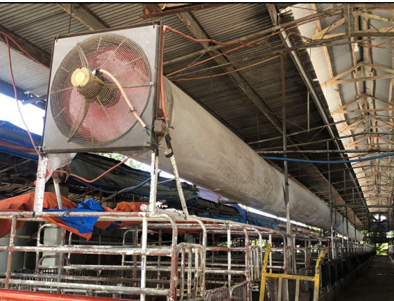
此處雖然是開放式豬舍，江董事長透過自製風管搭配豬欄上方通氣孔洞，將風確實送到豬欄下的母豬
