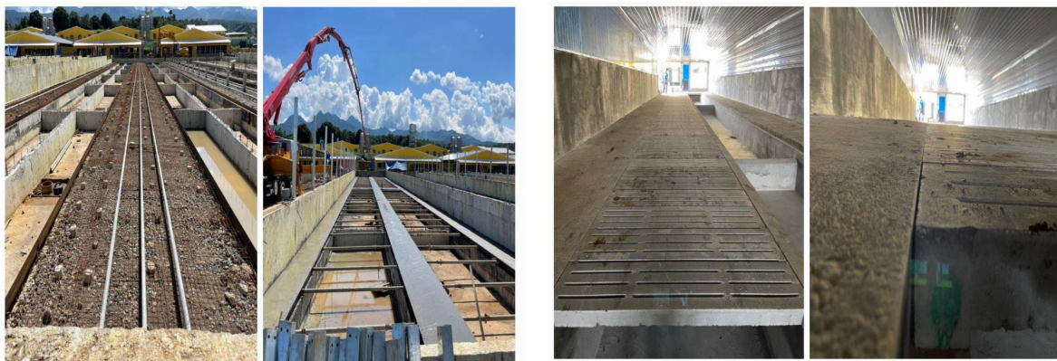
圖 2-4 以角鋼固定糞尿溝位置 (左圖) 與 成品公差只有 1~2 mm (右圖)
