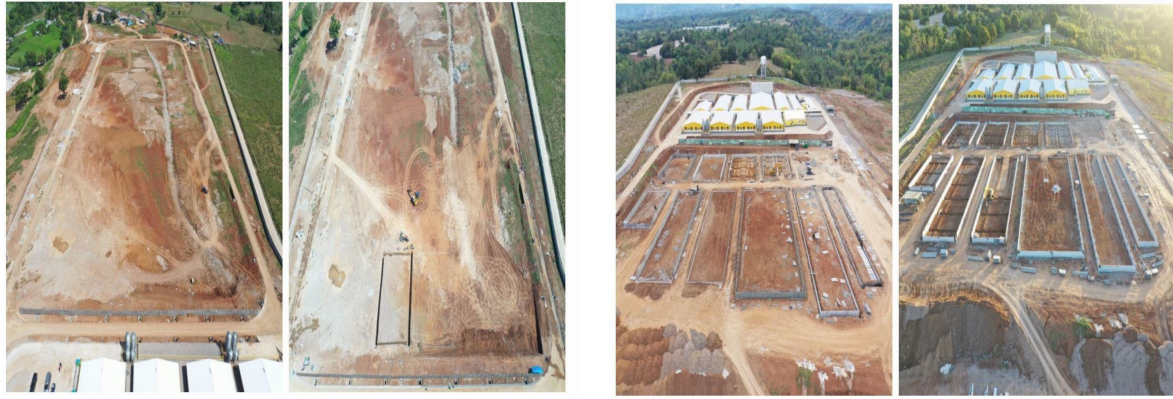
圖 2-3 場域整地 (左圖) 與 塑膠模板成模 (右圖)
