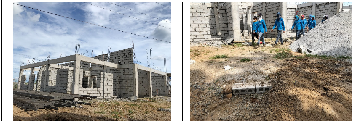
菲律賓水泥牆皆以空心磚內部灌水泥方式堆砌
