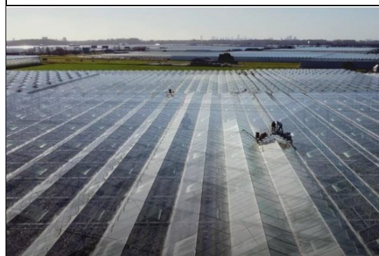
圖 55.PAR+塗布施作現場（官網提供）
