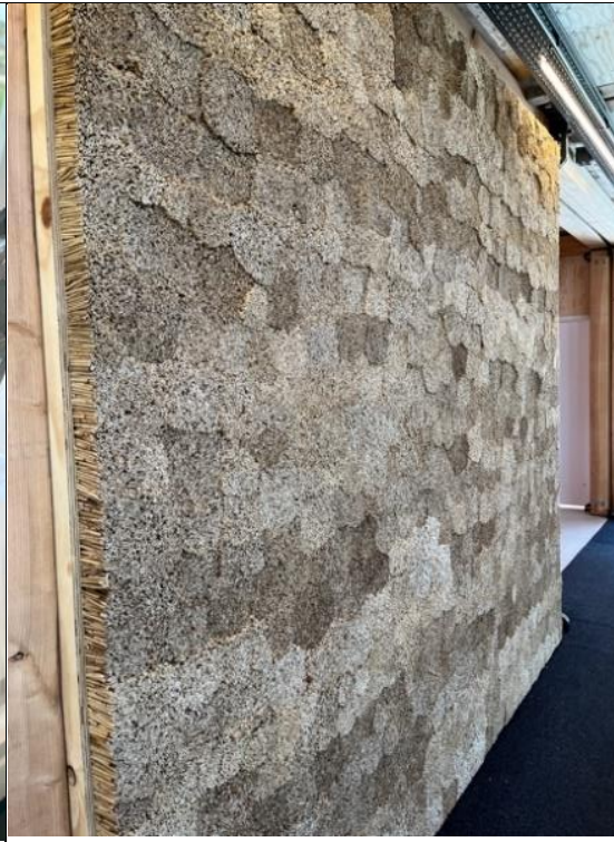
圖 48.運用農業廢棄資材作為建物牆面
