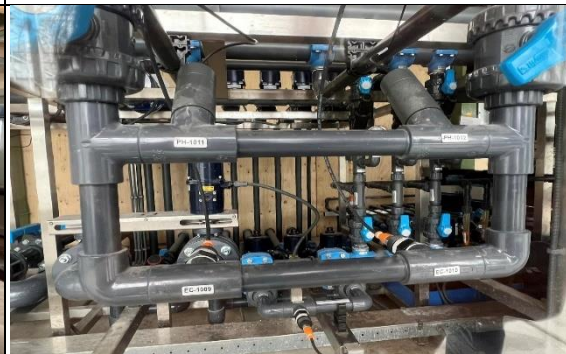
圖 60.養液管線上有 pH 和 EC 感測器監測
