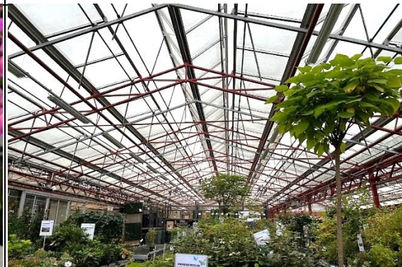
圖 82.賣場是溫室改建的，採光好，溫室屋頂的氣窗可隨天氣變化開啟或關閉
