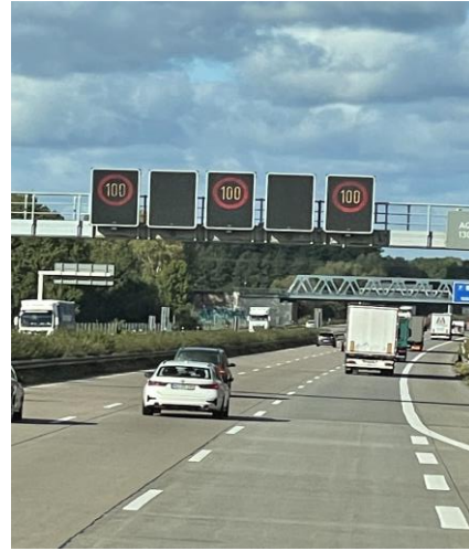
分車道速限可變標誌
