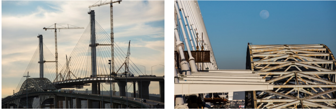
圖 B2 加州長灘區傑洛戴斯蒙橋梁改建專案，新雙塔斜張橋與舊鋼桁梁橋比對
