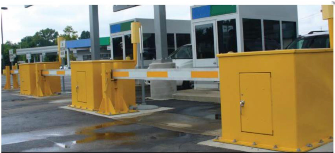
圖 E5 活動(自動墜落)式路障設施
