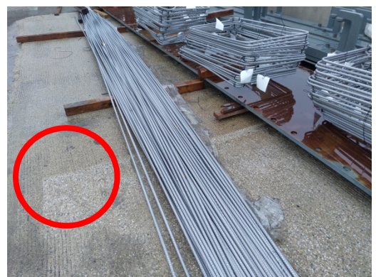
圖 S1 及 S2 以聚酯混凝土披覆，做為橋面鋪面，並可供間接判斷橋面裂縫
