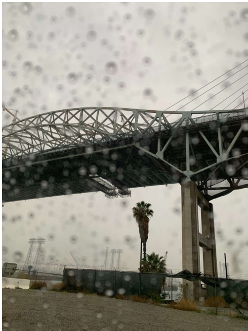
圖 G3 現有傑洛戴斯蒙鋼桁梁橋
