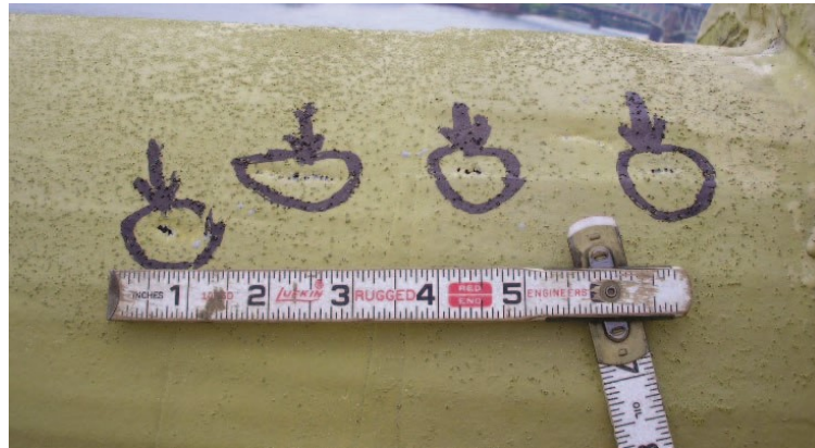
圖 M 目視檢測纜索保護狀況
