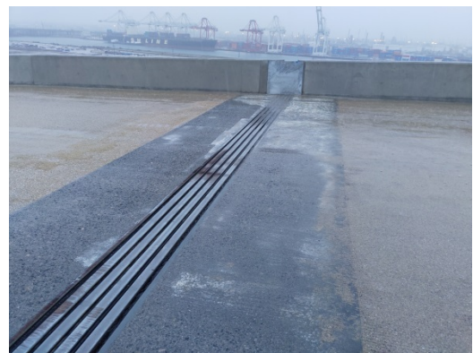
圖 R3 及 R4 模組型伸縮縫之預組立及完成狀況
