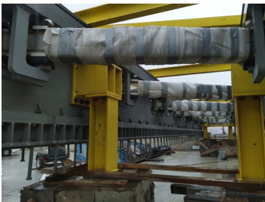
圖 R3 及 R4 模組型伸縮縫之預組立及完成狀況
