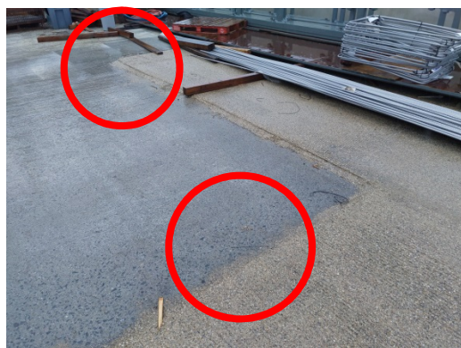
圖 S1 及 S2 以聚酯混凝土披覆，做為橋面鋪面，並可供間接判斷橋面裂縫
