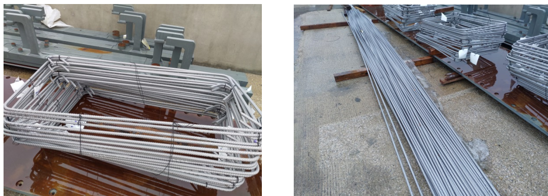
圖 P1 及 P2 於高鹽分環境，結構工程使用鍍鋅鋼筋
