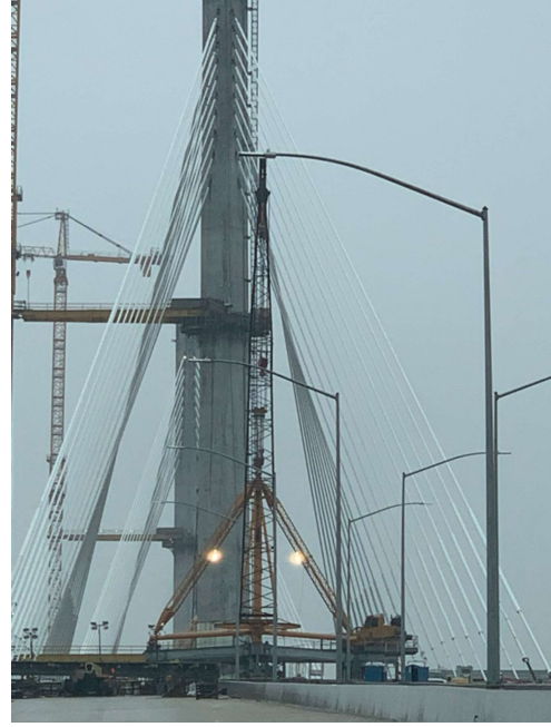
圖 G2 傑洛戴斯蒙橋梁鋼纜施工
