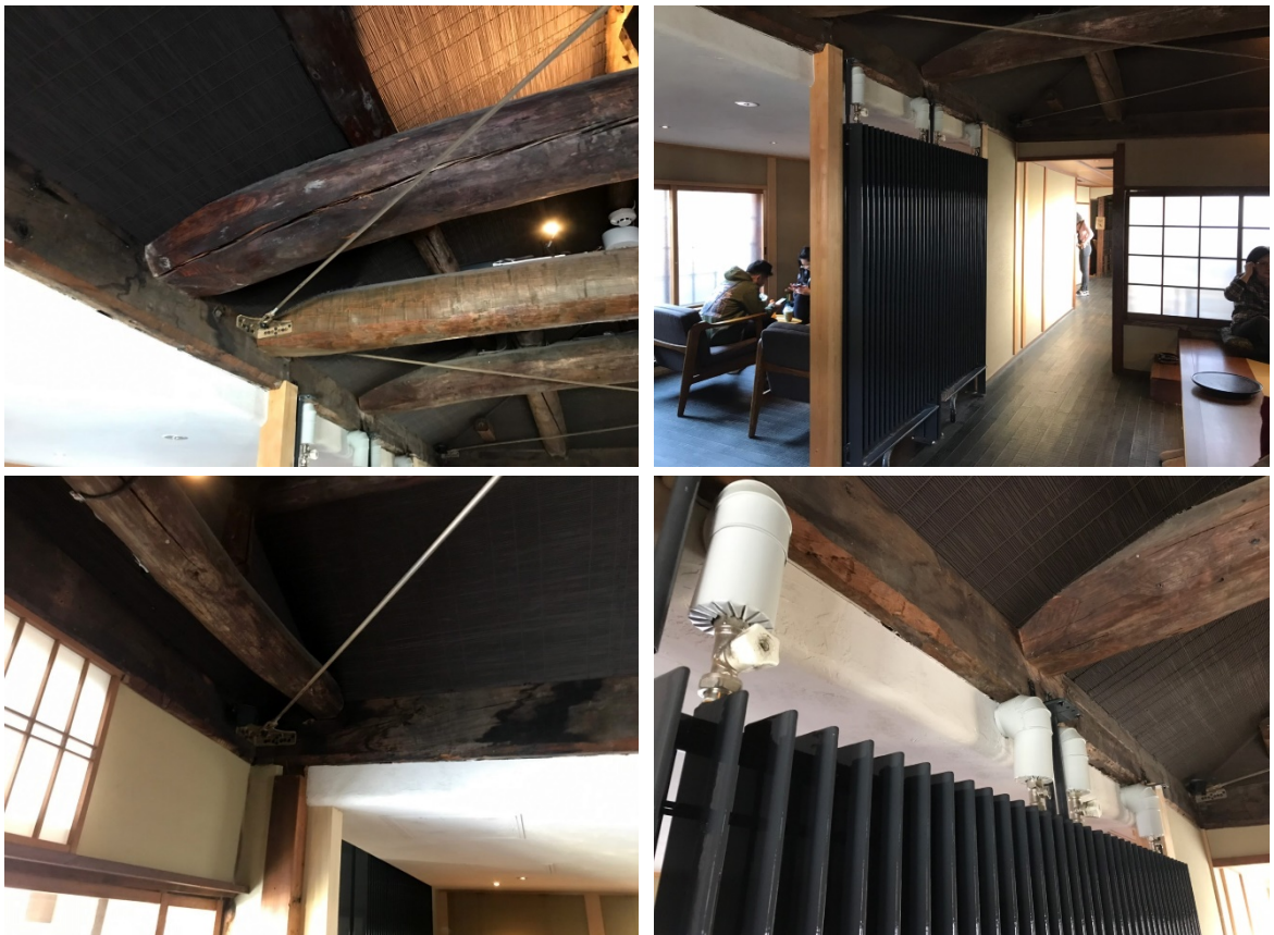
圖 2-2- 33 為保持結構的穩定性，除了在舊的結構上增加新木支撐也開著鋼索增加拉力
