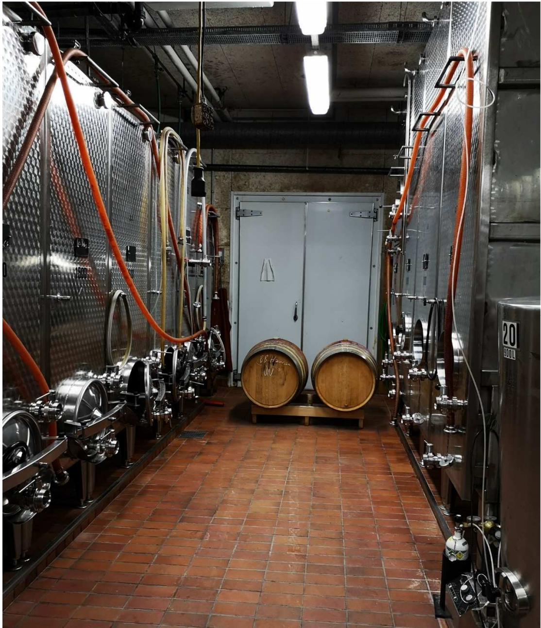
圖 13、葡萄酒發酵室（不同體積之發酵槽）。
