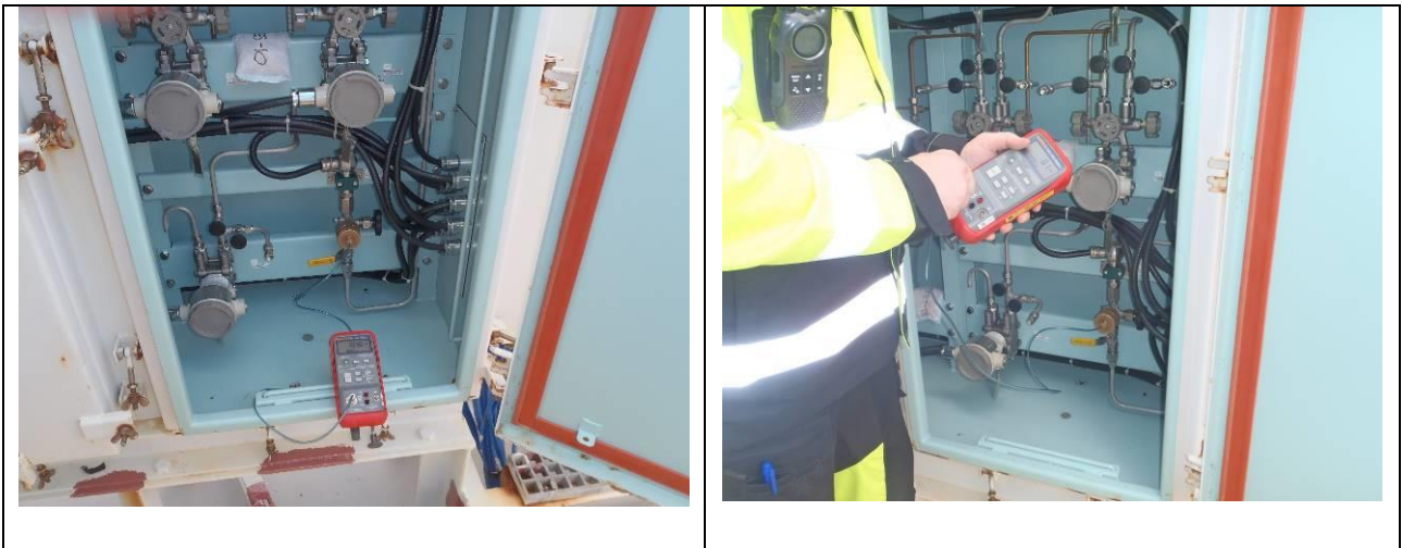
圖四、現場量測照片(儲槽壓力計校正)
