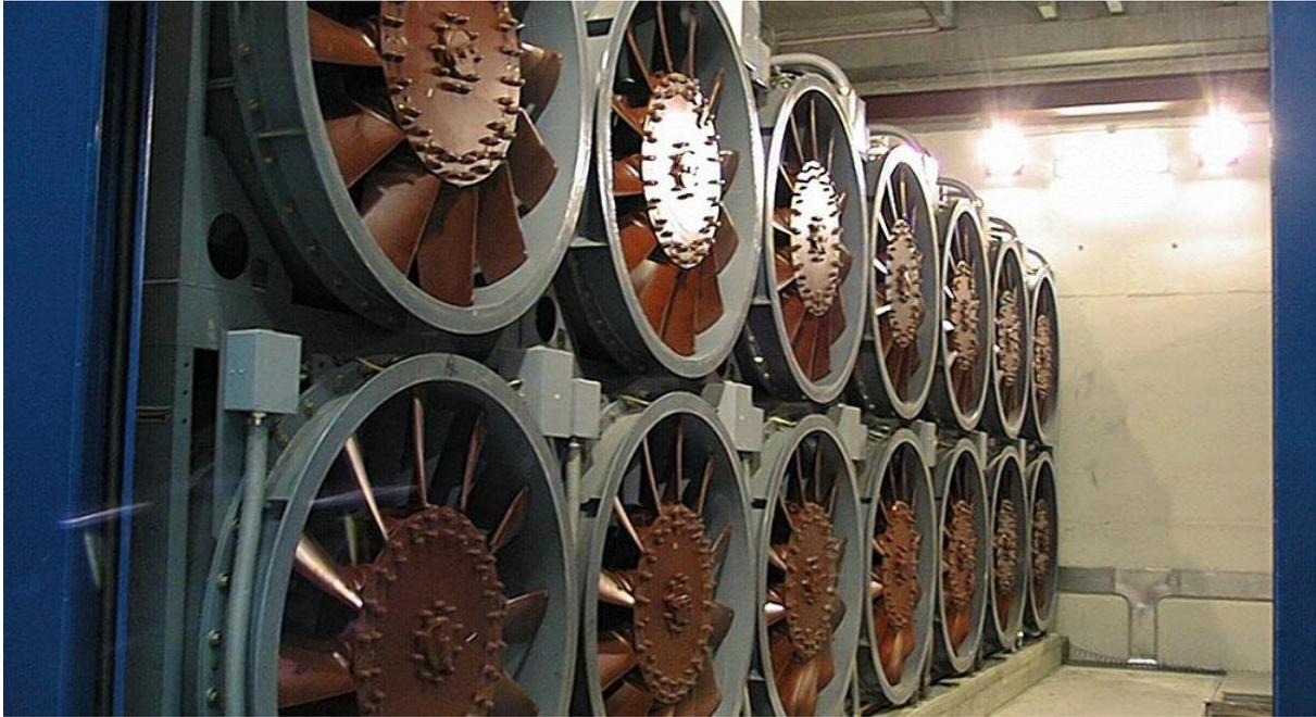
圖 35 GVPM 風洞 14 台風機
