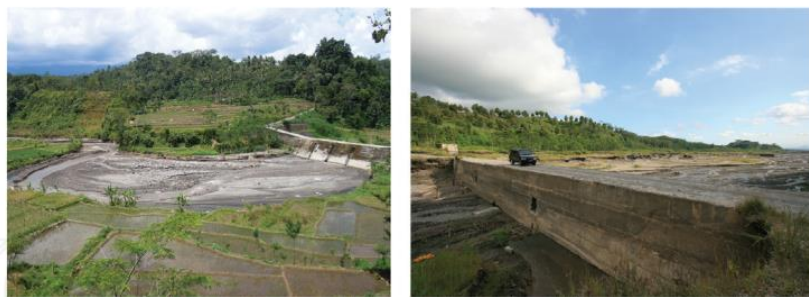
圖 10、Wlingi 水庫上游設置攔砂壩
