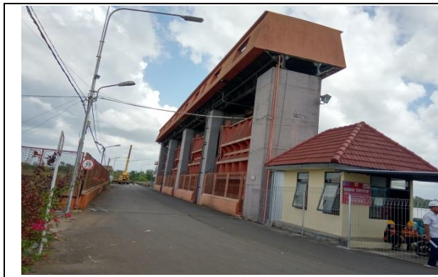
圖 12、Wlingi 水庫發電取水閘門
