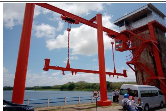
圖 21、Lodoyo 攔河堰天車吊掛設施情形
