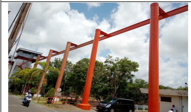
圖 20、Lodoyo 攔河堰天車軌道設置情形
