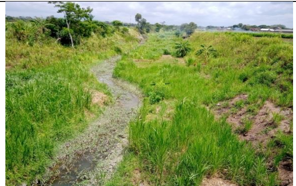
圖 17、Wlingi 水庫繞庫排砂渠道
