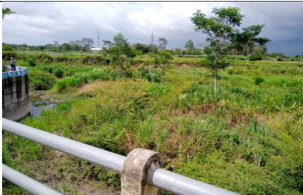
圖 16、Wlingi 水庫繞庫排砂渠道
