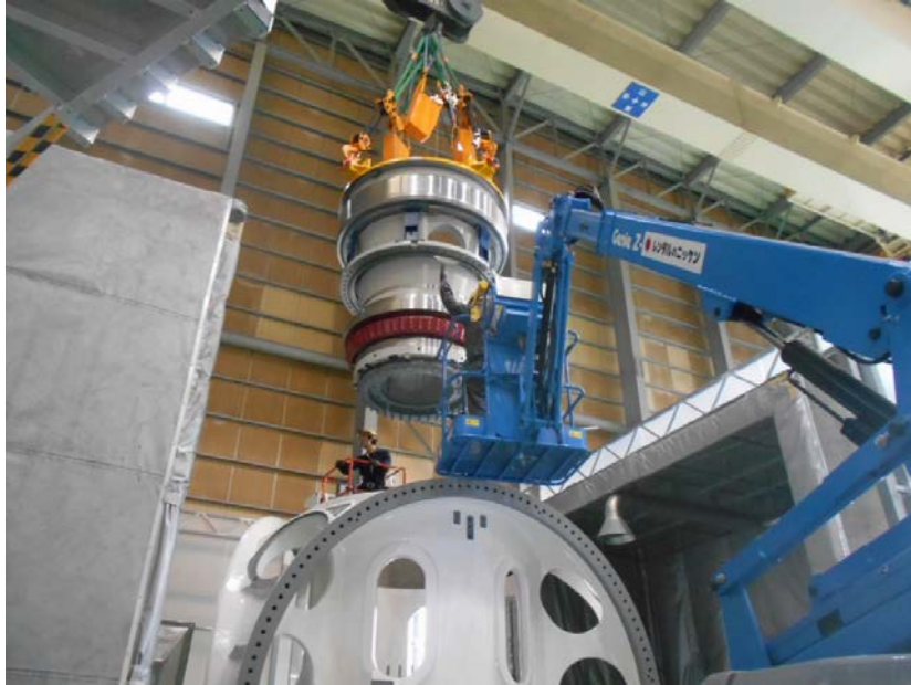
圖 25_固定主軸與輪殼收縮配合
