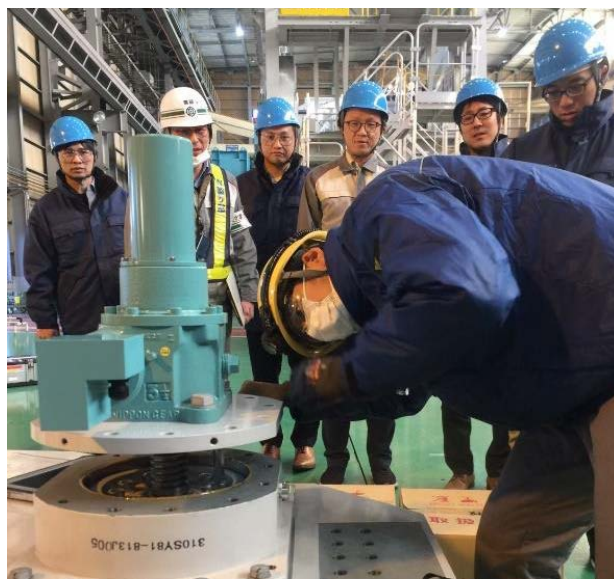
圖 38_工程人員確認轉子鎖鎖緊狀態
