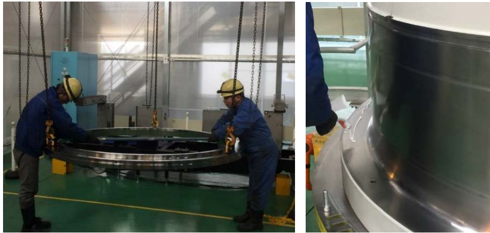
圖 20_主軸軸承加熱完成吊起確認膨脹程度(左圖)
