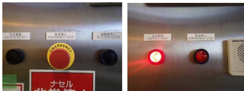
圖 70_緊急停止及安全跳脫測試
