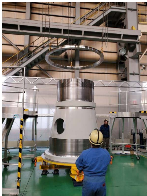
圖 22_主軸承（發電機側）吊起安裝於固定軸
