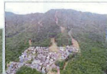
被災状況 (H30年7月)
