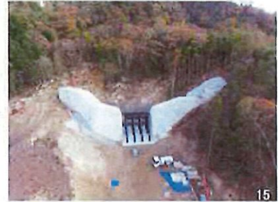
工事完了(令和元年12月3日)
