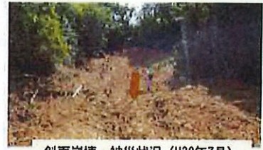
斜面崩壊・被災状況（H30年7月）
