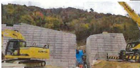
工事施工状況(令和元年11月末撮影)
