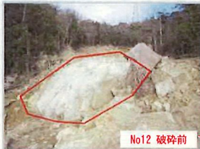
工事実施状況
