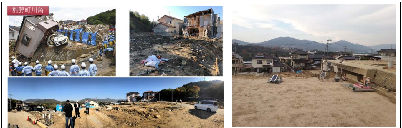
圖 27 廣島縣熊野町川角地區受災後情形/架設臨時性監測設備
