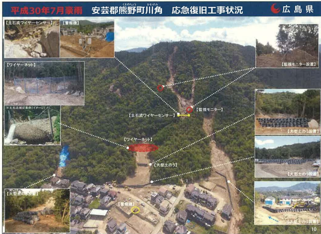
圖 28 広島縣熊野町川角地區災後緊急防治措施
