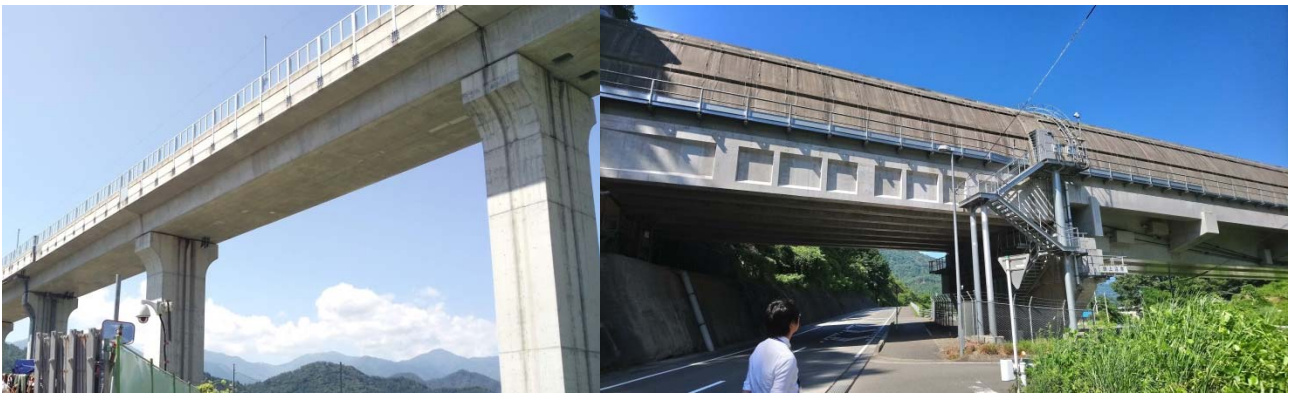
中央新幹線 高架橋路段“隔音牆”
