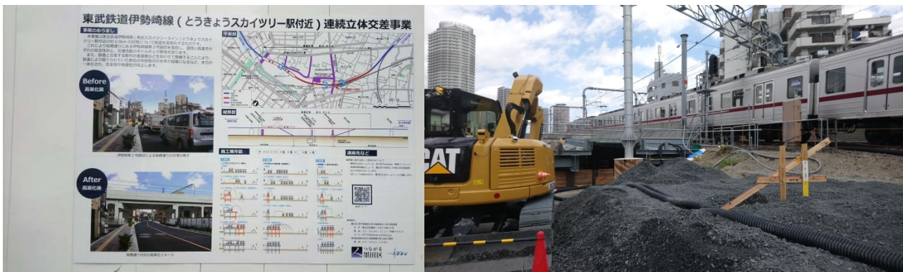
伊勢崎線天空樹站鐵路高架化工地
