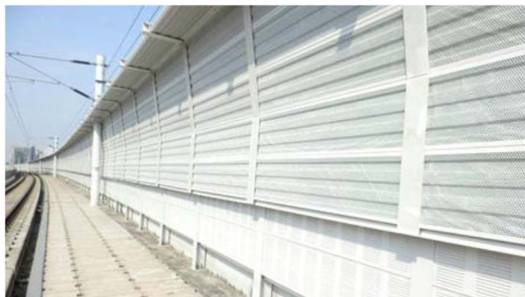
圖 1 現有高架橋配置隔音牆之型式
