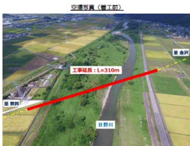
圖 日野川橋施工前照片
