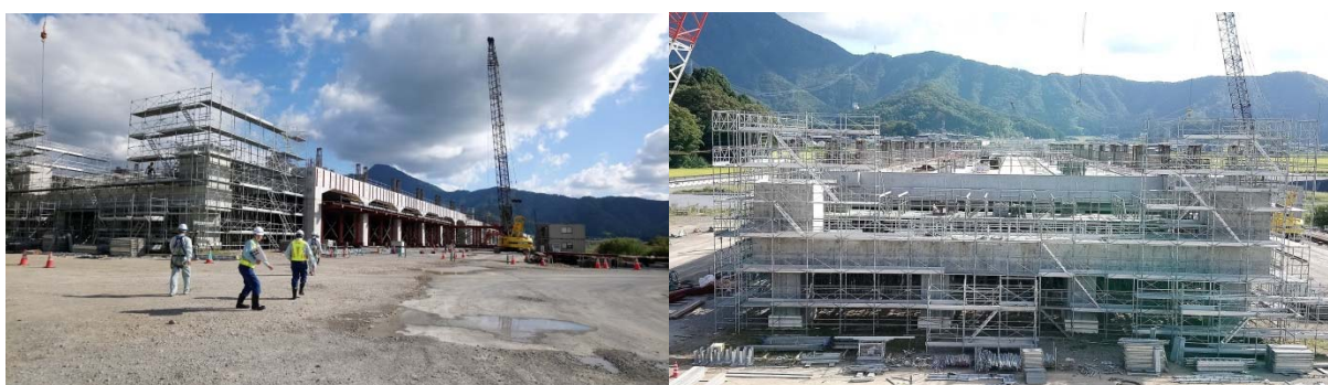
南越站新建工程施工
