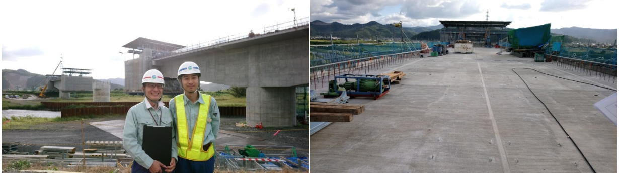
日野川橋施工照片
