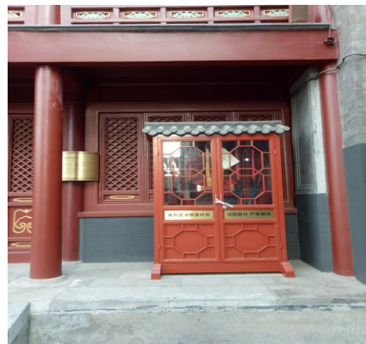
雍和宮消防設施
