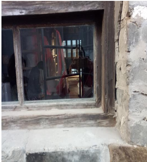
智珠寺大殿情形整修
